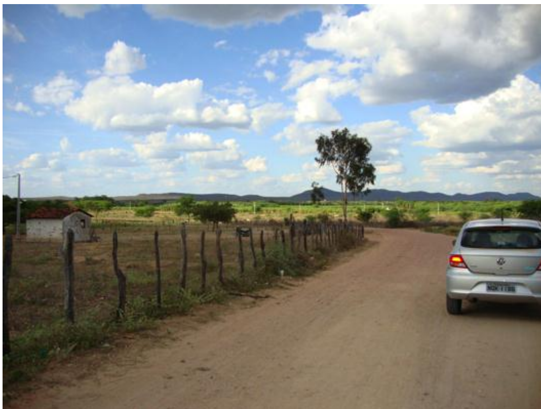
Foto 2: Estrada dentro do perímetro irrigado em solo arenoso e sem medidas de controle das águas pluviais.
