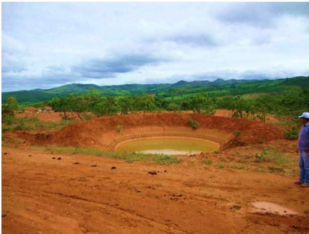
Foto 1: Exemplo de barraginha implantada no município de Guaraciama-MG.
