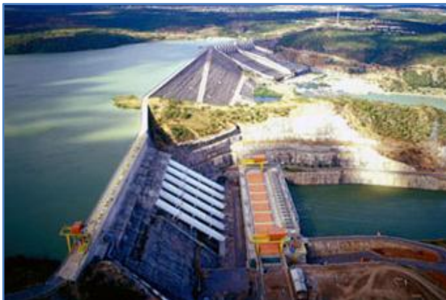
Figura 14 - Reservatório Xingó Fonte: CHESF, 2012
