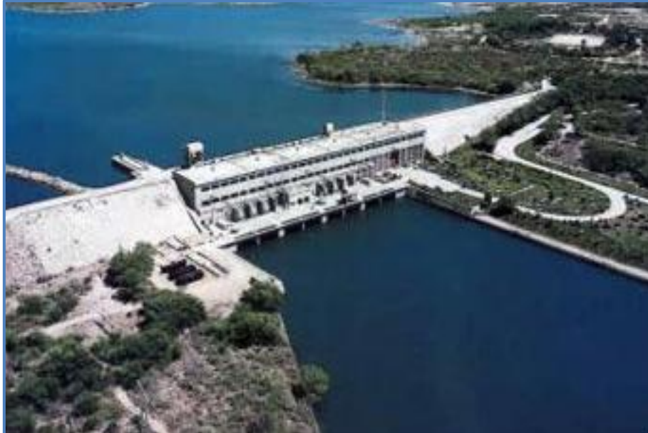
Figura 11 - Aproveitamento de Apolônio Sales Fonte: CHESF
