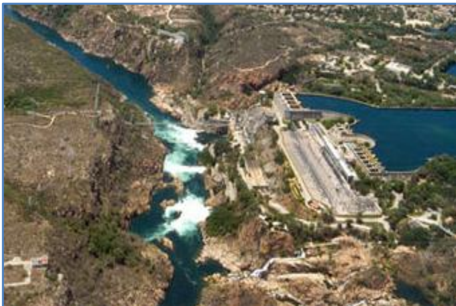
Figura 12 - Aproveitamento Hidrelétrico Paulo Afonso 3 Fonte: CHESF, 2012
