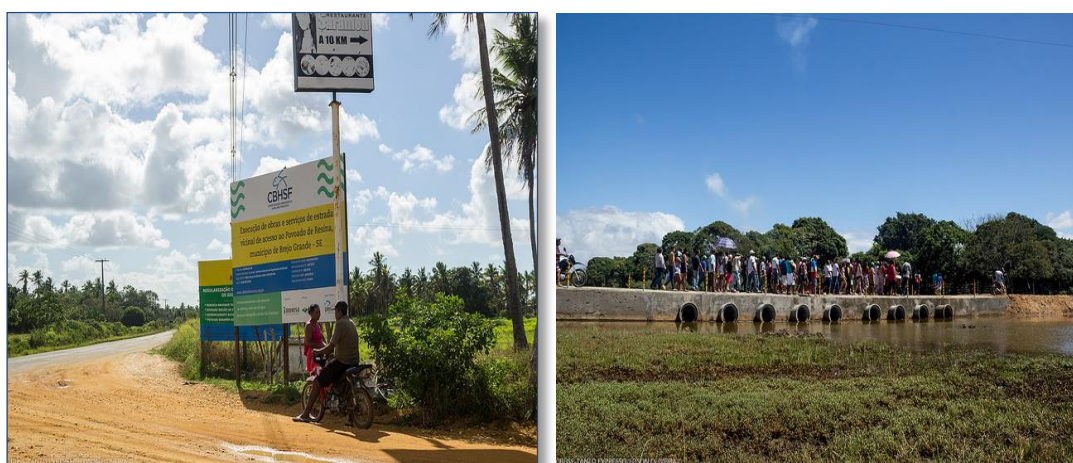
Figura 38 – Acervo fotográfico das obras e serviços de adequação da estrada de acesso ao povoado da Resina, em Brejo Grande, SE (Fonte: TANTO Expresso, 2018).
