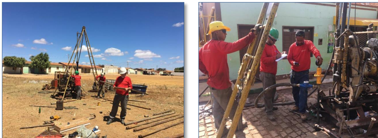
Figura 30 – Execução de sondagens na área urbana do município de Lapão, Médio São Francisco. (Fonte: CONSOMINAS Engenharia, 2018)
