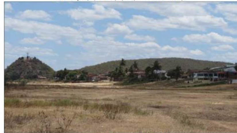
Foto 5- Casas passíveis de inundação a partir de 4.000 m 3 /s, abaixo da cota da Rua Povoado Campo Alegre, a montante do centro de Pão de Açúcar/AL, no dia 02/10/2013, com vazão de 1.288m 3 /s.
