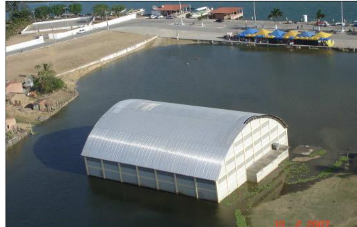
Foto 8 – Inundação da Lagoa do Padre e do Ginásio "O Ribeirão" (Traipu/AL), no dia 10/02/2007, com vazão de 6.549 m 3 /s.
