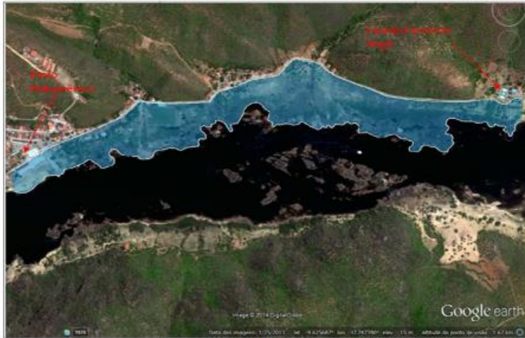
Figura 13 – Área levantada topograficamente entre o posto hidrométrico e a casa do antigo consórcio da construção da Usina de Xingó, Piranhas/AL.
