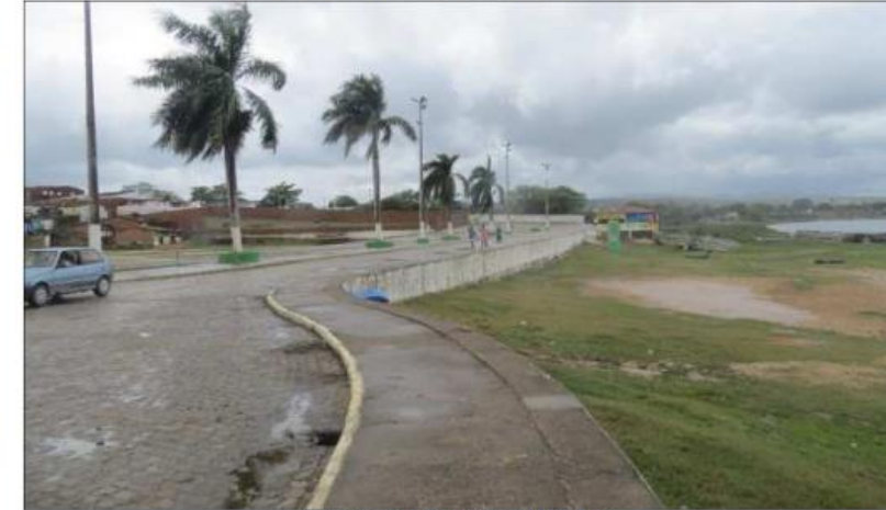
Foto 6 - Av. Beira Rio (Traipu/AL), no dia 15/10/2013, com vazão de 1.424 m 3 /s.
