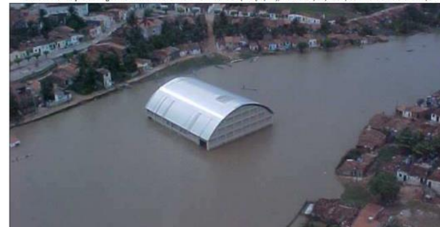
Foto 9 – Inundação da Lagoa do Padre e do Ginásio "O Ribeirão" (Traipu/AL), no dia 02/02/2004, com vazão de 8.842m 3 /s.
