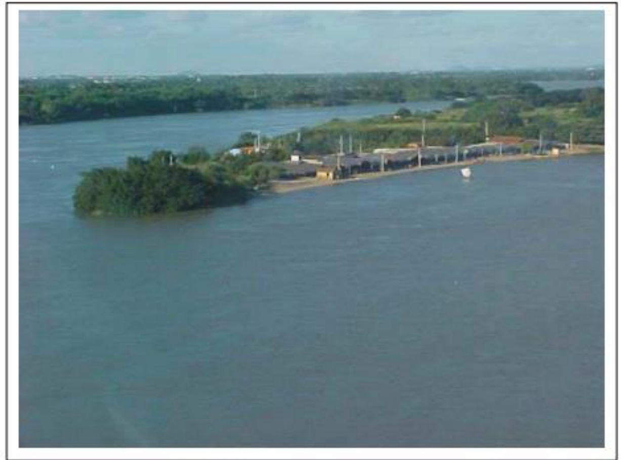
Foto 04 – Situação do Balneário da Ilha do Rodeadouro no dia 14/04/04, com defluência média diária da Usina de Sobradinho de 1.796 m 3 /s
