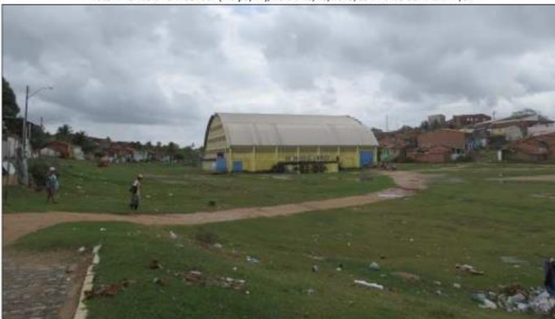
Foto 7 - Ginásio "O Ribeirão" (Traipu/AL), no dia 15/10/2013, com vazão de 1.424 m³/s.
