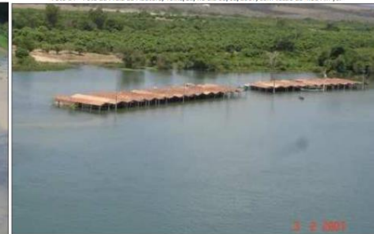
Foto 14 – Foto da Praia da Aduadora, Telha/SE, no dia 03/02/2007, com vazão de 4.014 m 3 /s.
