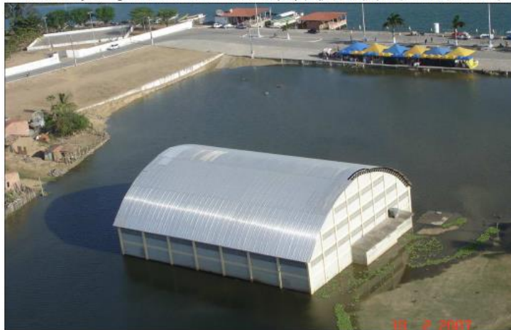
Foto 8 – Inundação da Lagoa do Padre e do Ginásio "O Ribeirão" (Traipu/AL), no dia 10/02/2007, com vazão de 6.549 m³/s.
