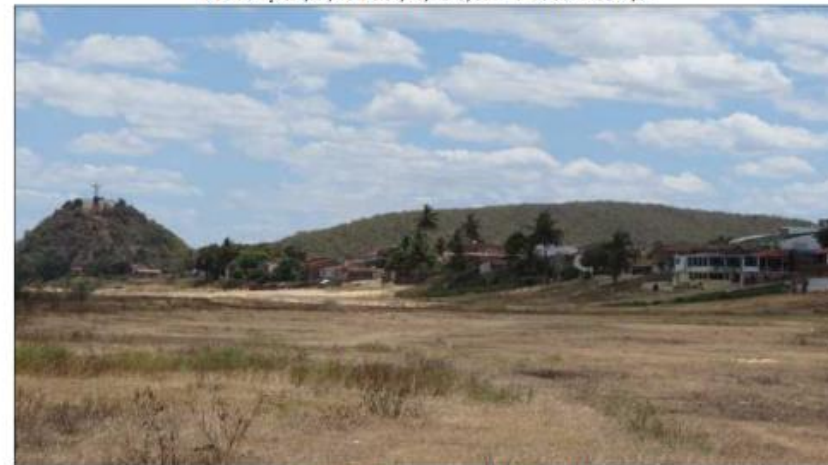
Foto 5- Casas passíveis de Inundação a partir de 4.000 m 3 /s, abaixo da cota da Rua Povoado Campo Alegre, a montante do centro de Pão de Açúcar/AL, no dia 02/10/2013, com vazão de 1.288m 3 /s.
