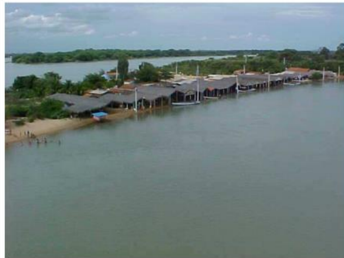
Foto 02 – Situação do Balneário da ilha do Rodeadouro no dia 22/02/05, com defluência média diária da Usina de Sobradinho de 3.023 m 3 /s
