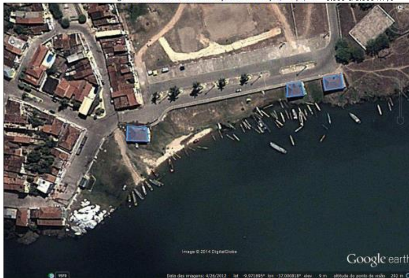
Figura 19– Bares da Orla Fluvial sujeitos a inundação, Traipu/AL. 6.000 a 8.000 m³/s
