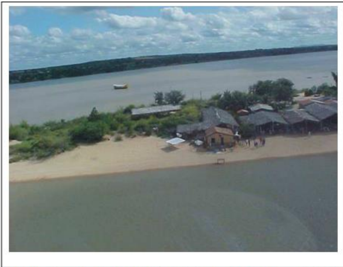
Foto 03 – Situação do Balneário da Ilha do Rodeadouro no dia 13/04/04, com defluência
