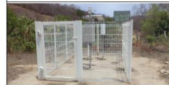
Foto 5 - Córrego da Velha - Araçuaí (21/09/2015)
