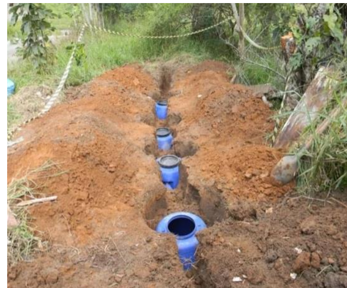
Construção de Fossas Sépticas
