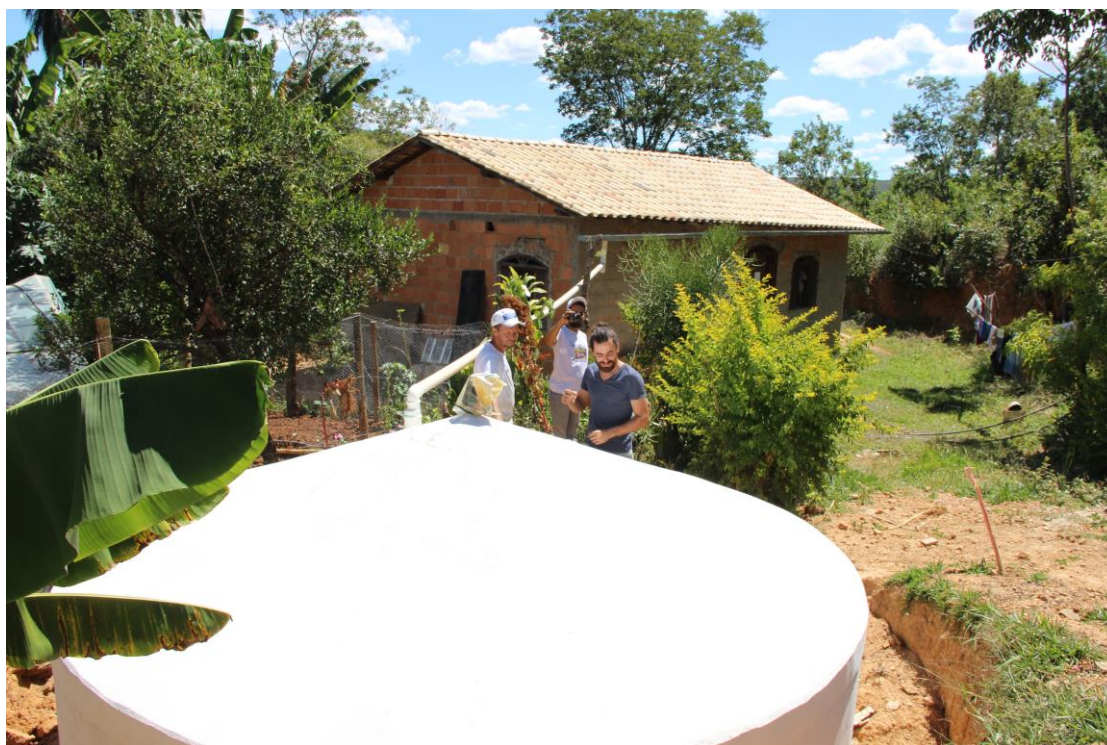
Figura 3.6. Abastecimento de água de domicílio rural do Município de Jaboticatubas-MG através de “água de chuva armazenada em cisterna” em junho de 2016.
