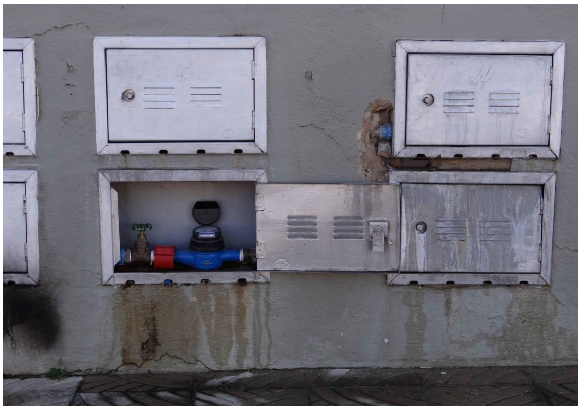
Figura 3.1. Abastecimento de água por “rede geral de distribuição”, mostrando detalhe de contadores para registro de consumo de água em domicílios urbanos do Município de Sete Lagoas-MG em julho de 2016. Mesmo tratando-se da forma de abastecimento de água mais adequada podem ocorrer perdas físicas, como observado acima.
