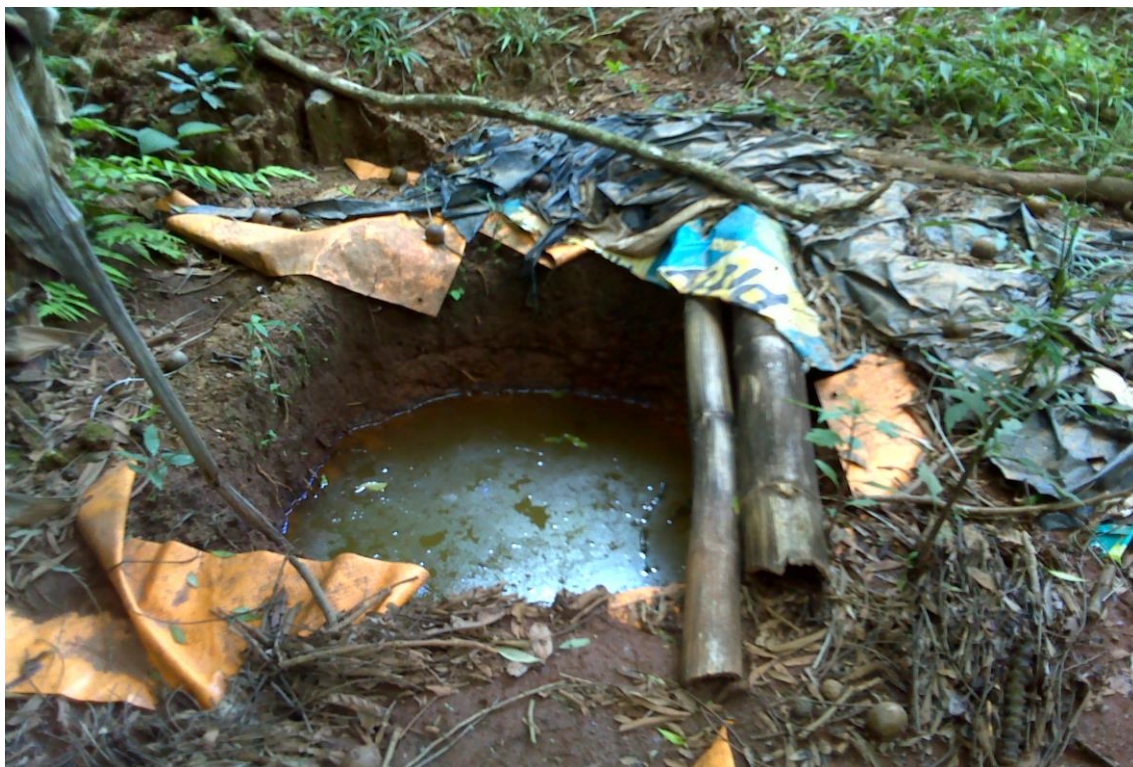
Figura 4.3. Esgotamento sanitário através de “fossa rudimentar” em domicílio rural da comunidade de Maquiné, distrito de Ravena, Município de Sabará-MG.
