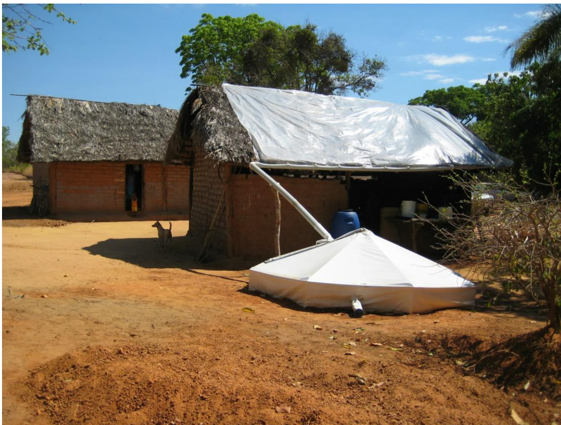
Figura 3.5. Abastecimento de água de domicílio rural do Município de Conceição do Tocantins-TO através de “água de chuva armazenada em cisterna” em outubro de 2008.
