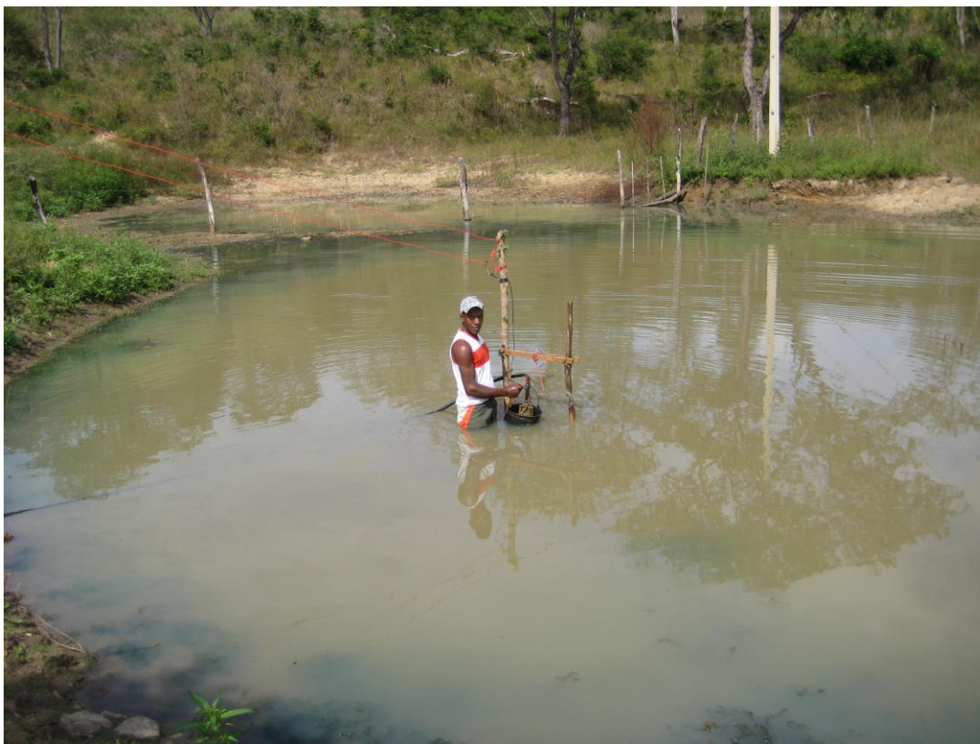
Figura 3.9. Abastecimento de água de domicílio rural diretamente de “rio, açude, lago ou igarapé”, apresentando como exemplo uma “barraginha” situada no Município de Berilo-MG em 2010. As barraginhas atuam como pequenos “açudes temporários” com o objetivo de colher a água das enxurradas, proporcionando infiltração rápida entre uma chuva e outra (ver mais detalhes no Capítulo 10).
