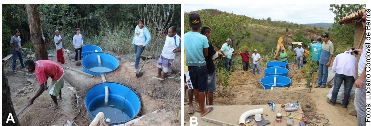
Figura 10.13. Treinamentos para construção de Fossas Sépticas Biodigestoras em 2016: em Santa Luzia-MG (A) e em Itaobim-MG (B).
