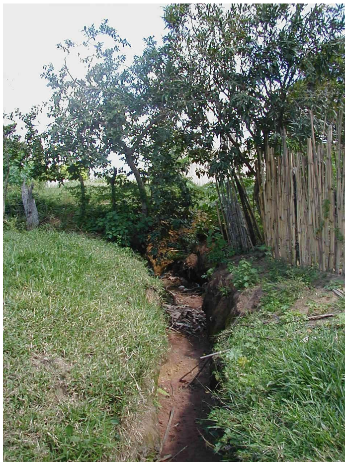
Figura 4.4. Esgotamento sanitário através de “vala” de domicílio rural do Município de Lagoa da Prata-MG em janeiro de 2002.
