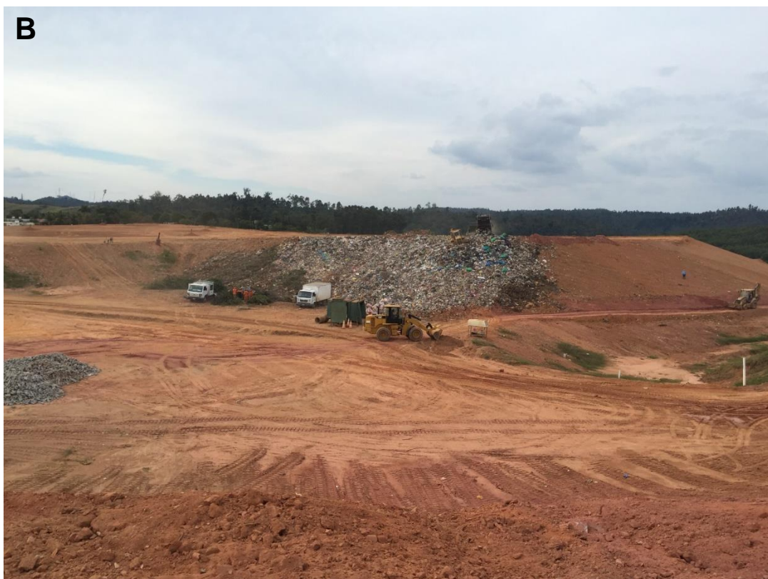
Figura 5.8. Tipos de destinação ou disposição final de resíduos sólidos domiciliares coletados por serviço de limpeza em diferentes locais e épocas: vazadouro a céu aberto (“lixão”) no Município de Lagoa da Prata-MG em janeiro de 2002 (A) e frente operacional do aterro sanitário de Ipatinga-MG, localizado no município de Santana do Paraíso-MG, que atualmente recebe resíduos de 11 municípios do leste de Minas Gerais em julho de 2016 (B).
