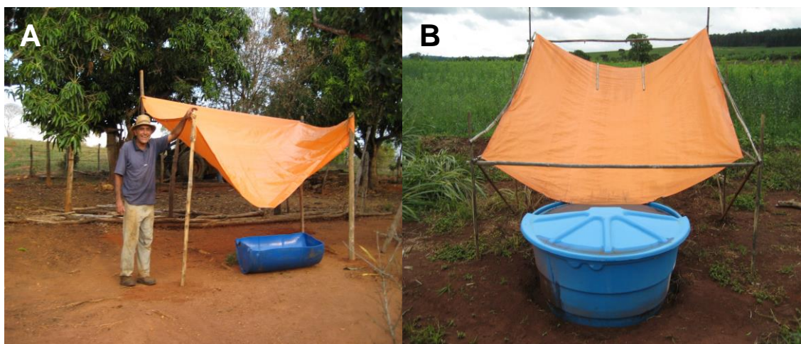
Figura 3.7. Abastecimento de água de domicílio rural através de “água de chuva armazenada de outra forma”: galões, tanques de material plástico, etc.: Comunidade de Diamante, município de Cordisburgo-MG (A) e Embrapa Milho e Sorgo, município de Sete Lagoas-MG em 2009 (B).
