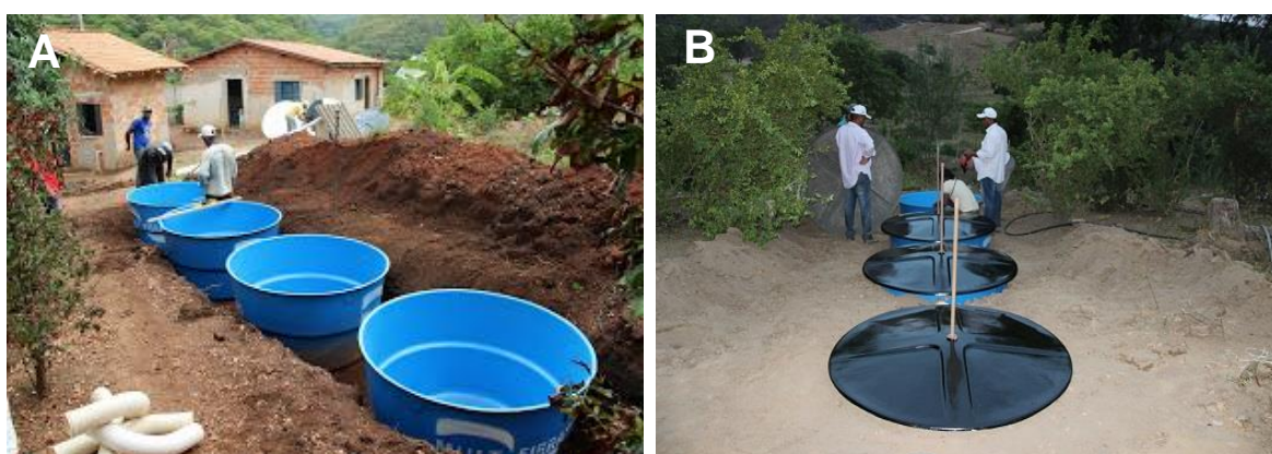
Figura 10.14. Fossas Sépticas Biodigestoras em construção pela equipe do Projeto e voluntários em 2016: em Jequitibá-MG (A) e em Itaobim-MG (B).
