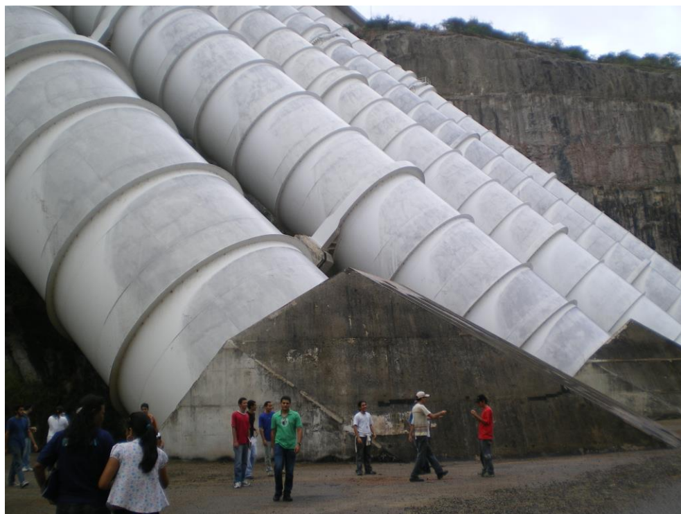
Penstock da Usina Hidroelétrica de Xingó (Foto do autor)
