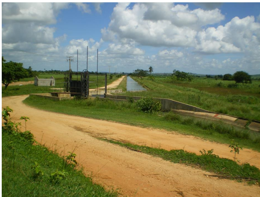
Perímetro de irrigação Boacica, em Alagoas, com água do rio São Francisco (Foto do autor)
