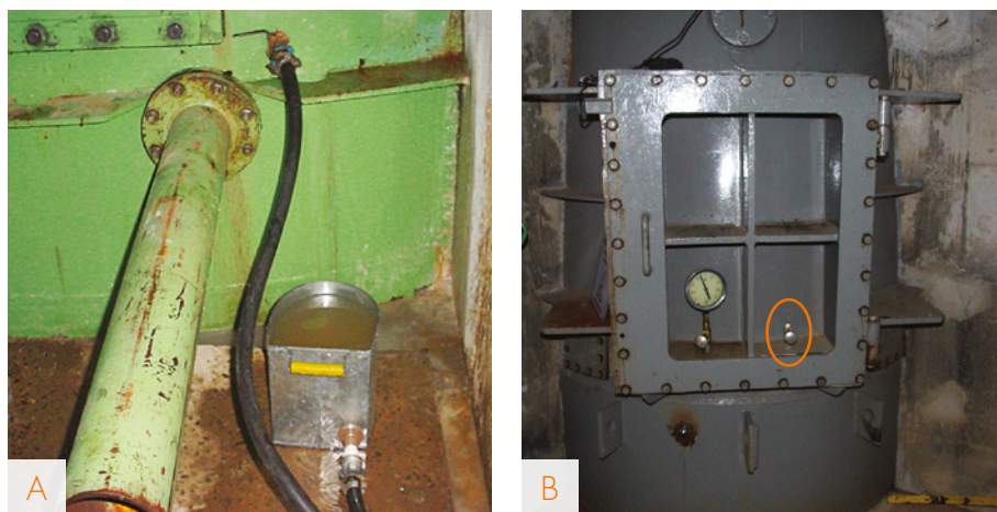
FIGURA 5 – Instalação de pontos de monitoramento do oxigênio dissolvido na escotilha do tubo de sucção na UHE Funil (A) e UHE Rosal (B).
