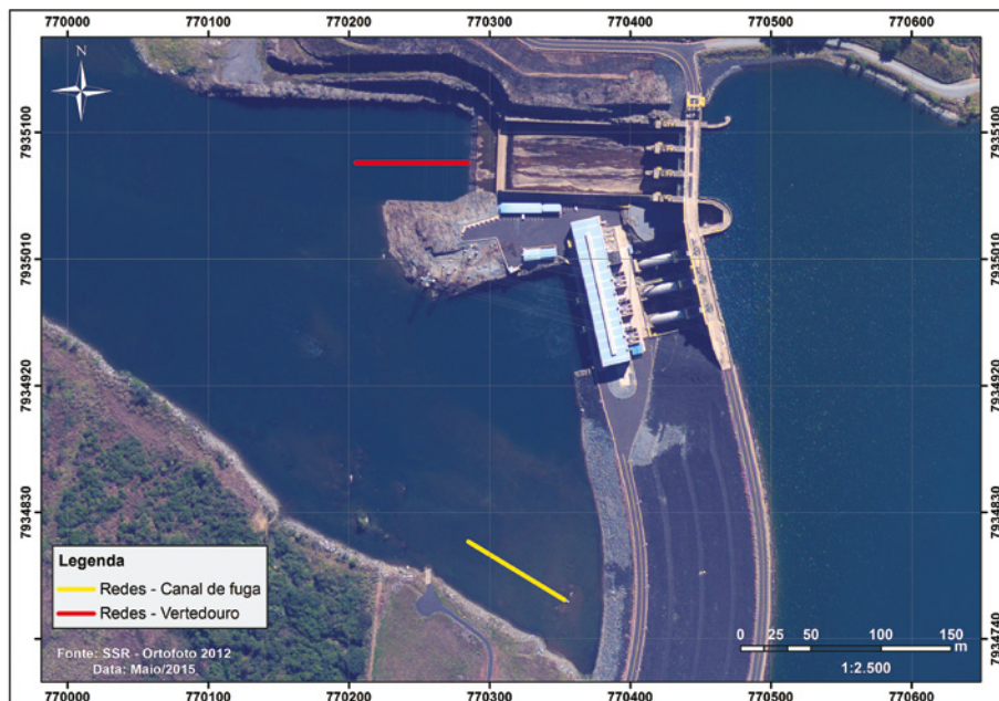
FIGURA 1 – Rio Araguari na área da UHE Amador Aguiar II com indicação da posição das redes de emalhar na área adjacente ao canal de fuga (em amarelo) e na fossa de erosão do vertedouro (em vermelho).
