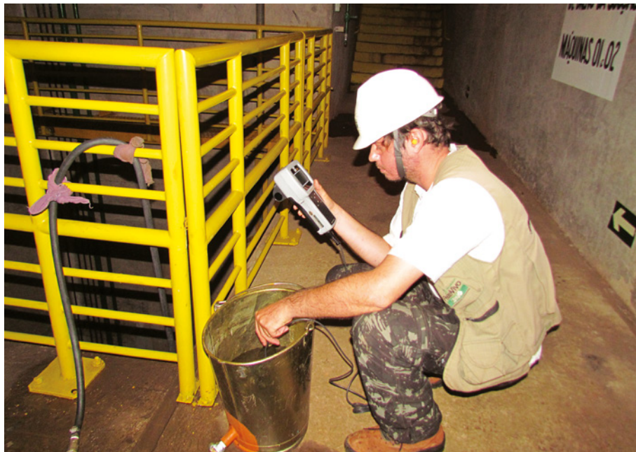
FIGURA 5 – Determinação do oxigênio dissolvido da água do tubo de sucção durante drenagem de unidade geradora na UHE Amador Aguiar I. Foto: Átila Rodrigues Araújo.
