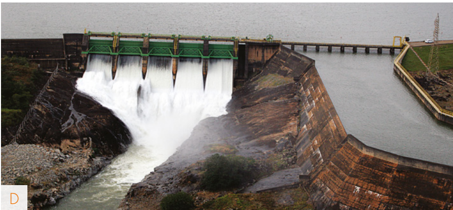
FIGURA 2 – Locais de aprisionamento de peixes na bacia de dissipação do vertedouro, mostrando população indo para capturar peixes após o fechamento do vertedouro, na UHE Jaguará (A) e UHE Itutinga (B). Bacia de dissipação do vertedouro após obras para remoção dos locais de aprisionamento na UHE Jaguará (C) e UHE Itutinga (D).
