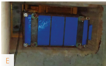
FIGURA 7 – Plataforma montada no interior do tubo de sucção da UHE São Simão (A). Caixa de transporte de peixes sendo posicionada na saída da escotilha do tubo de sucção (B). Rampa posicionada na entrada da caixa de transporte para transferência dos peixes resgatados no tubo de sucção (C). Caixa de transporte sendo içada através dos block outs da usina (D e E). Caixa de transporte sendo colocada no caminhão que levará os peixes resgatados para a área de soltura (F). Foto A: Átila Rodrigues. Foto B a F: Alexandre Peressin.
