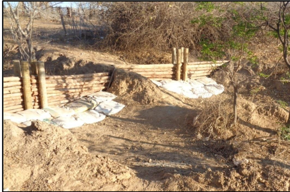
Figura 15: Construção de Paliçadas. Fonte: Localmaq, 2015.
