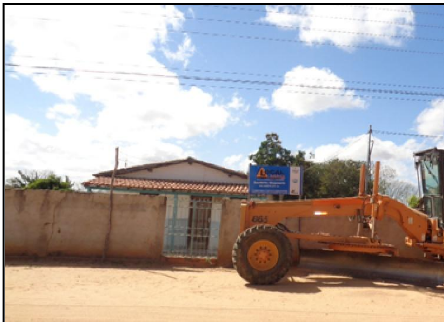
Figura 18: Foto do Alojamento/Escritório. Fonte: Localmaq, 2015.
