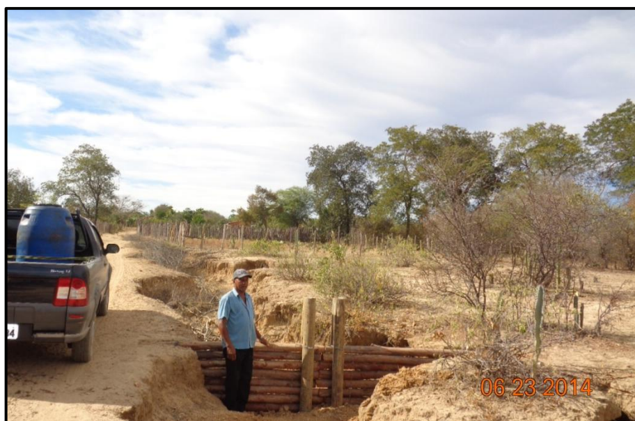
Figura 14: Construção de Paliçadas. Fonte: Localmaq, 2015.
