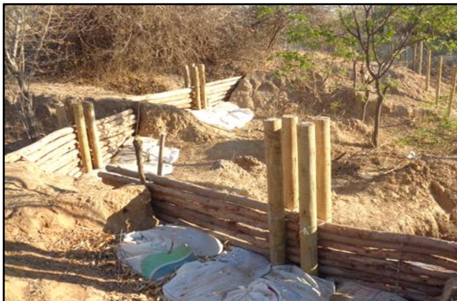
Figura 16: Construção de Paliçadas. Fonte: Localmaq, 2015.
