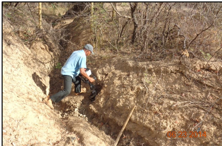
Figura 13: Construção de Paliçadas. Fonte: Localmaq, 2015.
