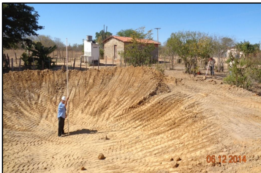
Figura 12: Construção de Barragem. Fonte: Localmaq, 2015.
