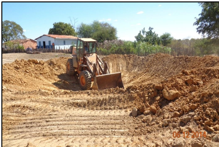
Figura 11: Construção de Barragem. Fonte: Localmaq, 2015.
