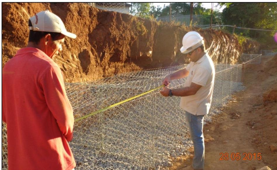
**Figura 18. Medição dos gabiões.**
