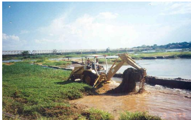
Limpeza do Canal de Captação
