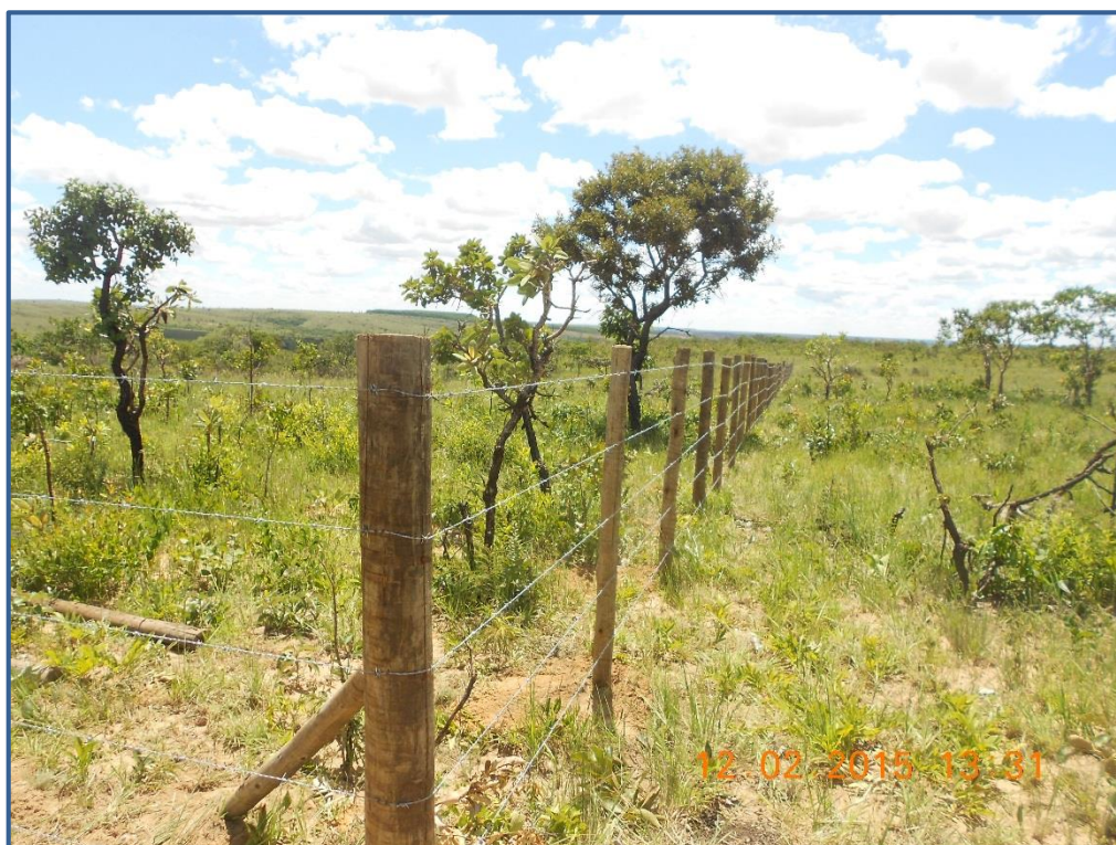
Figura 17: Cercamento de APP executado.
