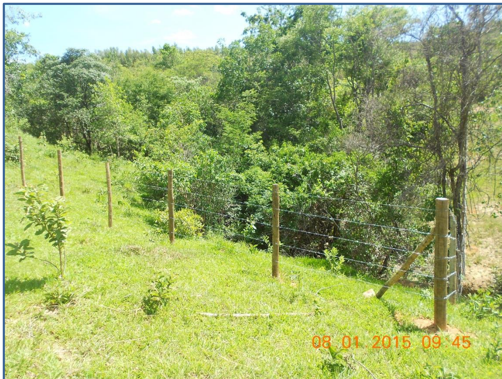
Figura 16: Cercamento de APP executado;
