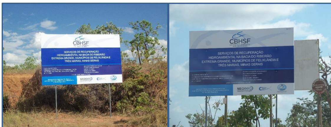
Figura 24: Retirada das placas de obra.
