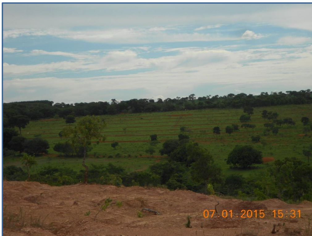
Figura 20: Terraços executados na RAD 03.
