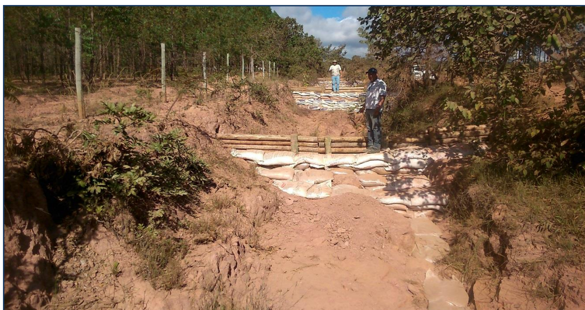
Figura 8: Fiscalização das paliçadas;
