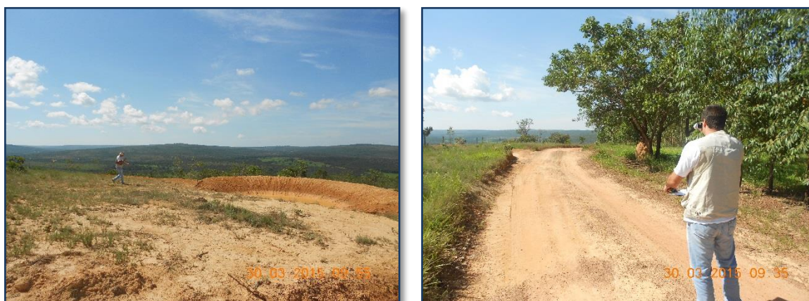
Figura 9: Fiscalização das estradas e barraginhas.
