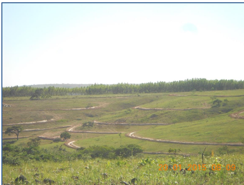
Figura 23: Terraço executado na RAD 08.
