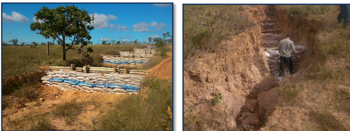
Figura 19: Paliçadas executadas.
