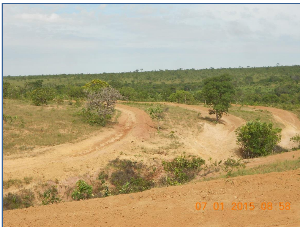
Figura 21: Terraço executado na RAD 07.
