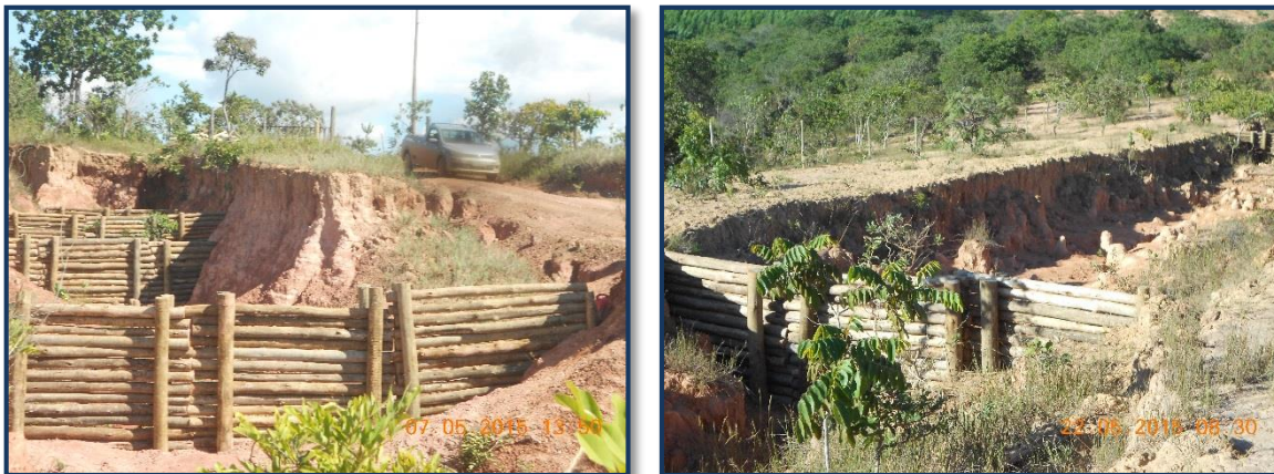
Figura 18: Execução das paliçadas.
