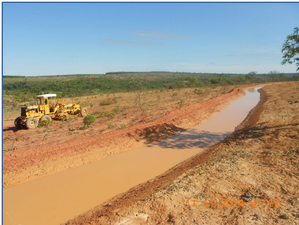
Figura 22: Terraço retendo água.
