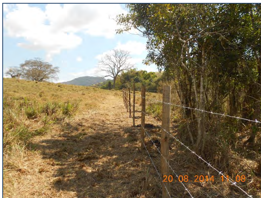
Figura 10: Cercamento de APP executado; Fonte: Neogeo, 2014
