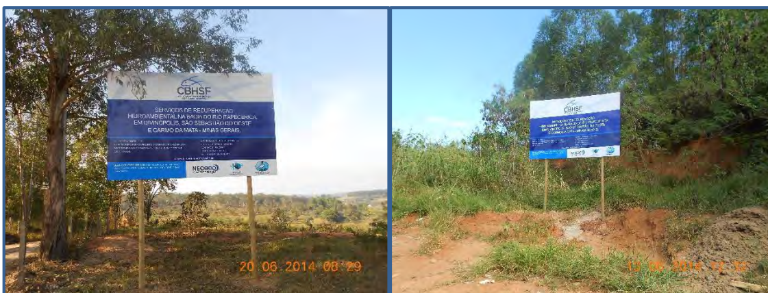
Figura 13: Retirada das placas de obra.
