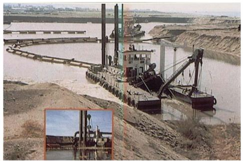
Figura 6. Remoção mecânica de sedimentos
