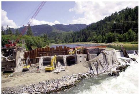
Figura 4. Etapa de uma remoção de barragem
