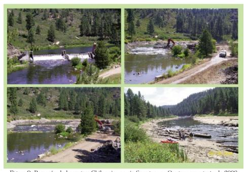
Figura 9. Remoção da barragem Chiloquin, no rio Sprague, no Oregon, em agosto de 2008
