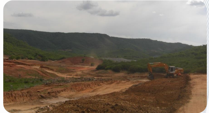
Reservatório Caiçara - Execução da escavação da fundação do barramento.
