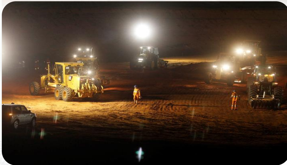
WBS 1113 - Reservatório Porcos – Trabalho Noturno
