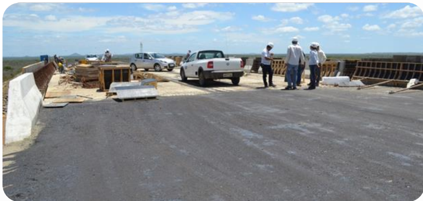
WBS 1505 - Ponte BR-428 - Concretagem do guarda-corpo.
