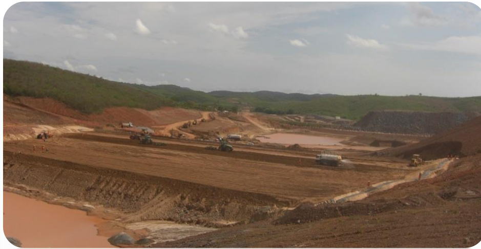
WBS 1111 - Reservatório Jati - Execução do espaldar de jusante e filtro horizontal (barramento principal).
