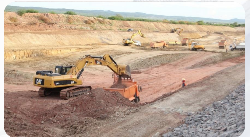
WBS 1234 - Escavação de canal anterior ao Túnel Cuncas I.
