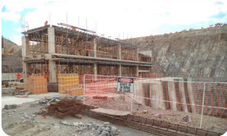
EBV-02 - Execução da montagem da forma e armação da laje do edifício de apoio.
