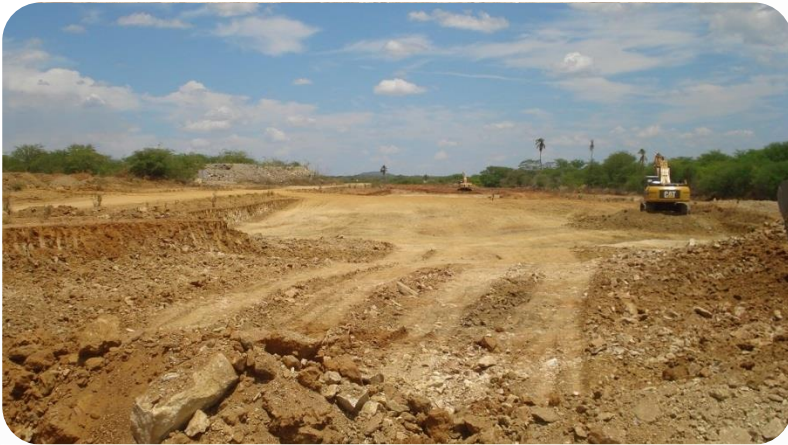
Reservatório Moxotó - Escavação do vertedouro
