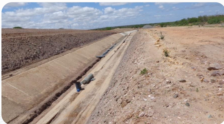
WBS 2206 - Segmento de canal - Execução da drenagem interna do fundo do canal
