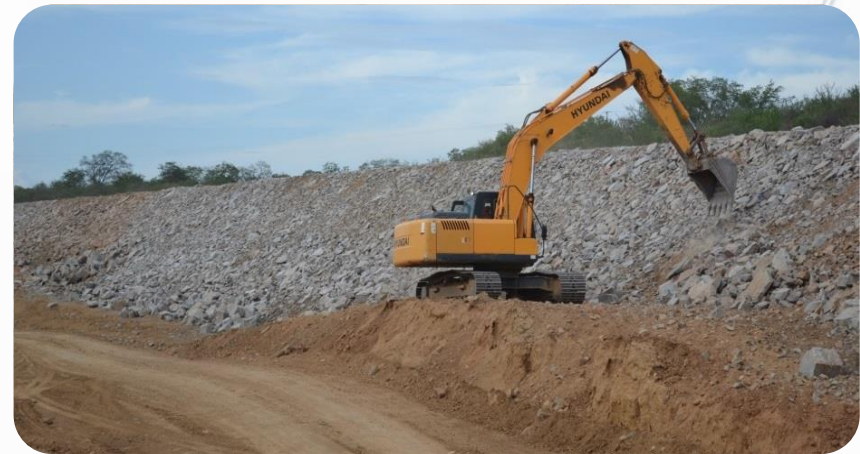
WBS 1215 - - Enrocamento de proteção na estaca 3595.
