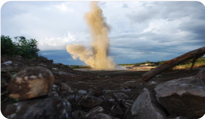
Túnel Monteiro - Detonação
