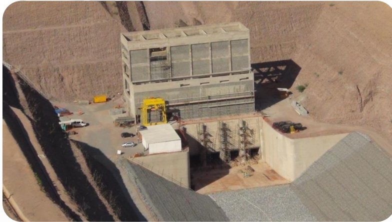
EBV-01 – Execução da alvenaria, montagem da ponte rolante e da tubulação da (peça em Y) na estação de bombeamento.
