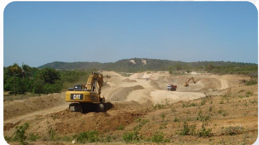
WBS 2226 - Segmento de canal - Escavação entre as estacas 9500 e 9520
