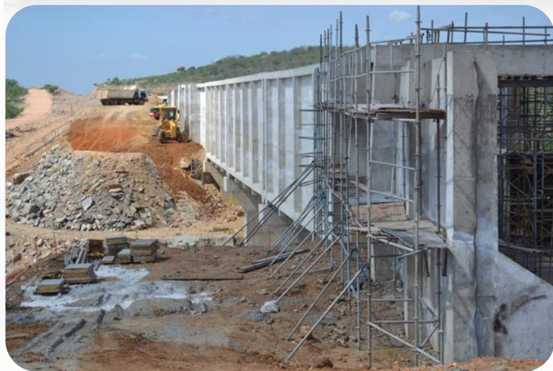
WBS 1305 - Aqueduto Logradouro - Vista geral da execução do reaterro à montante.
