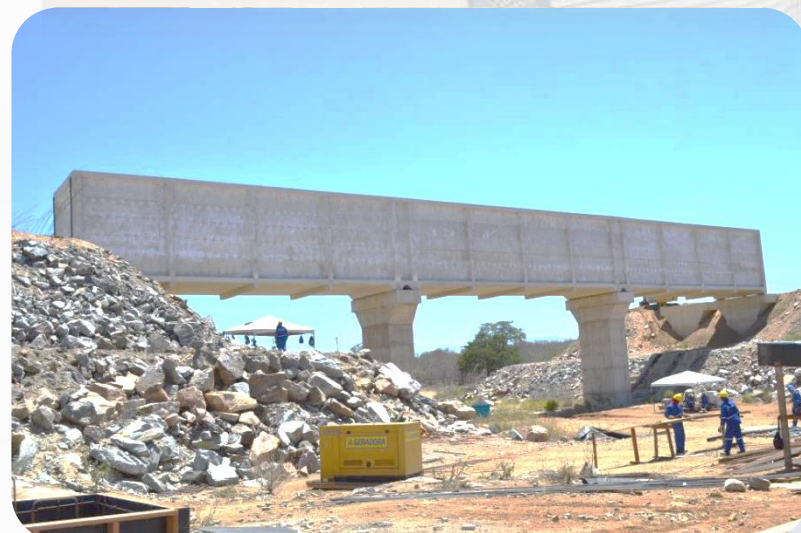
WBS 1306 - Aqueduto Saco da Serra
