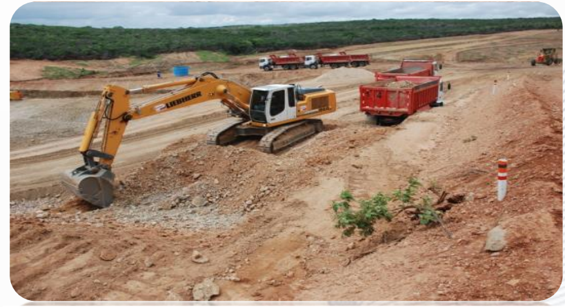
Reservatório Barro Branco - Execução da escavação do vertedouro
