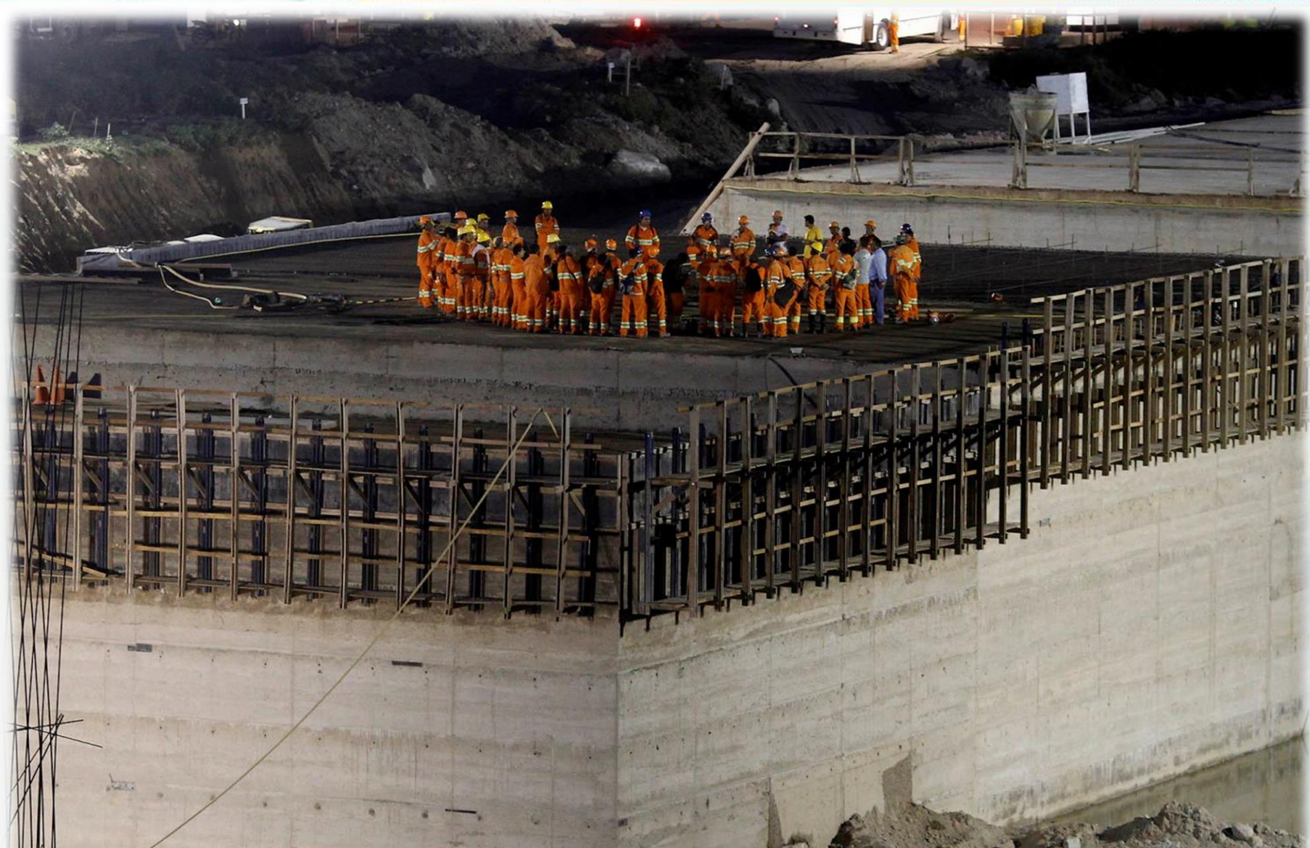
Reservatório Porcos - Execução de CCR no vertedouro.
