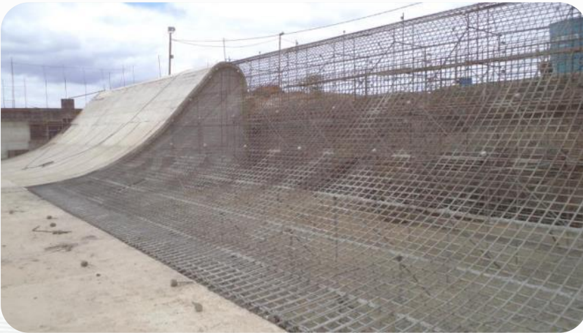
Execução do barramento do Reservatório Mangueira.
