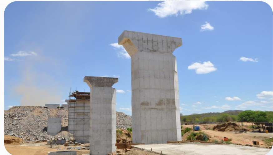
Aqueduto Salgueiro - Execução dos pilares e enrocamento.
