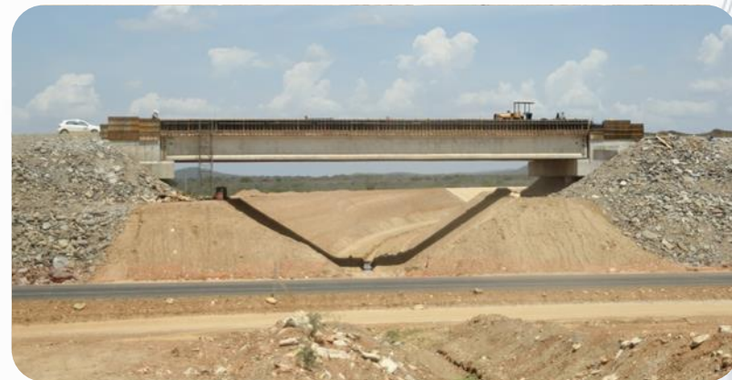
WBS 1505 - Ponte BR-428 – Execução do canal sob a ponte.
