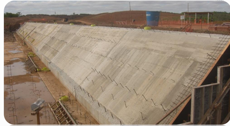
WBS 1111 - Reservatório Jati - Execução do vertedouro.
