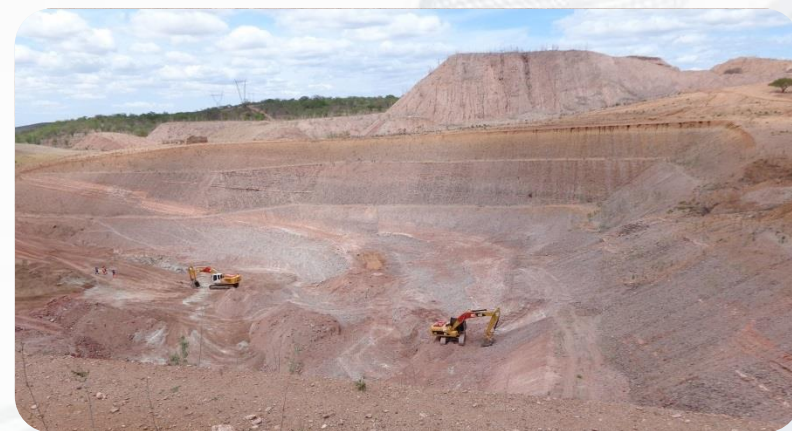
EBV-03 - Execução da escavação entre as estacas 1794 e 1795.
