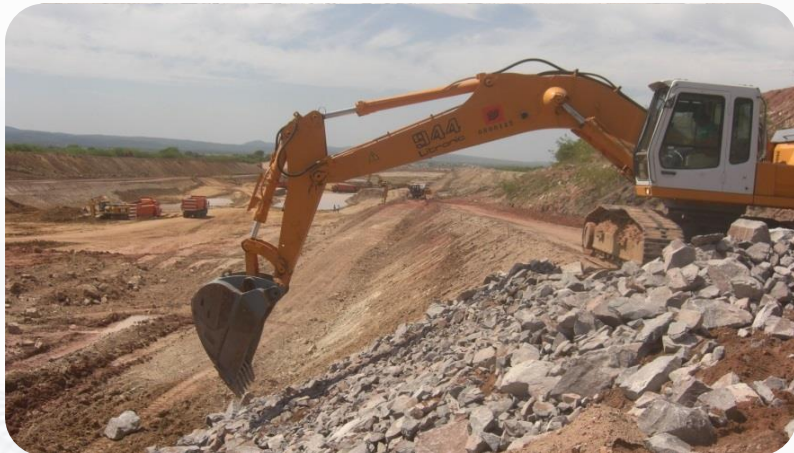
WBS 1234 - Segmento de canal - Execução de enrocamento de proteção.
