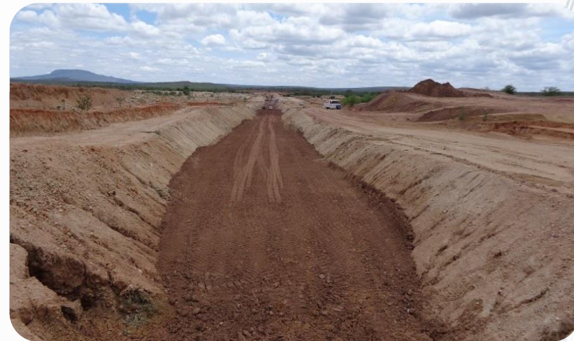
WBS 2106 - Reservatório Mandantes - Execução do aterro compactado do cut-off.
