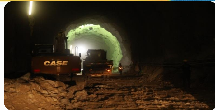
Túnel Cuncas I: frente de serviço de escavação.
