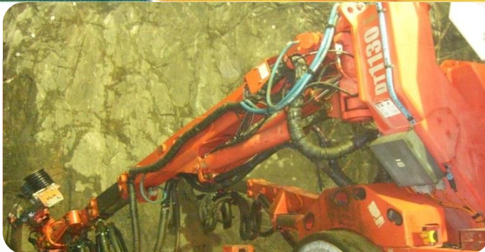
Túnel Cuncas I: em execução perfuração no sentido janela de acesso - emboque
