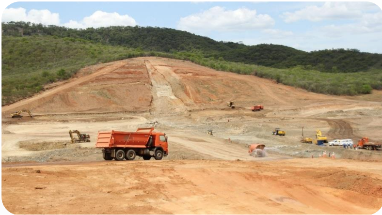
Reservatório Boa Vista - Em execução escavação do barramento.
