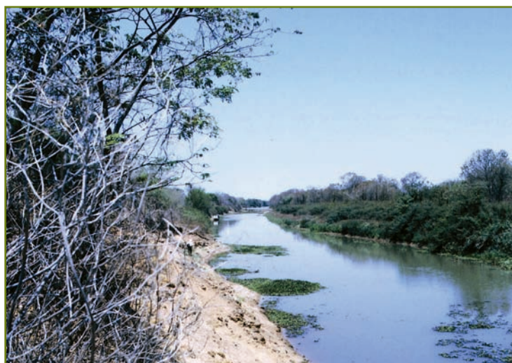
Figura 28 - Trecho eutrofizado do Rio Verde Grande próximo ao Município de Jaíba – MG (2003)
