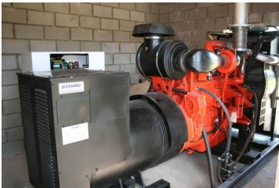
Figura 33 – Melhorias na ETE Pinheirinho, no município de Vinhedo-SP.
