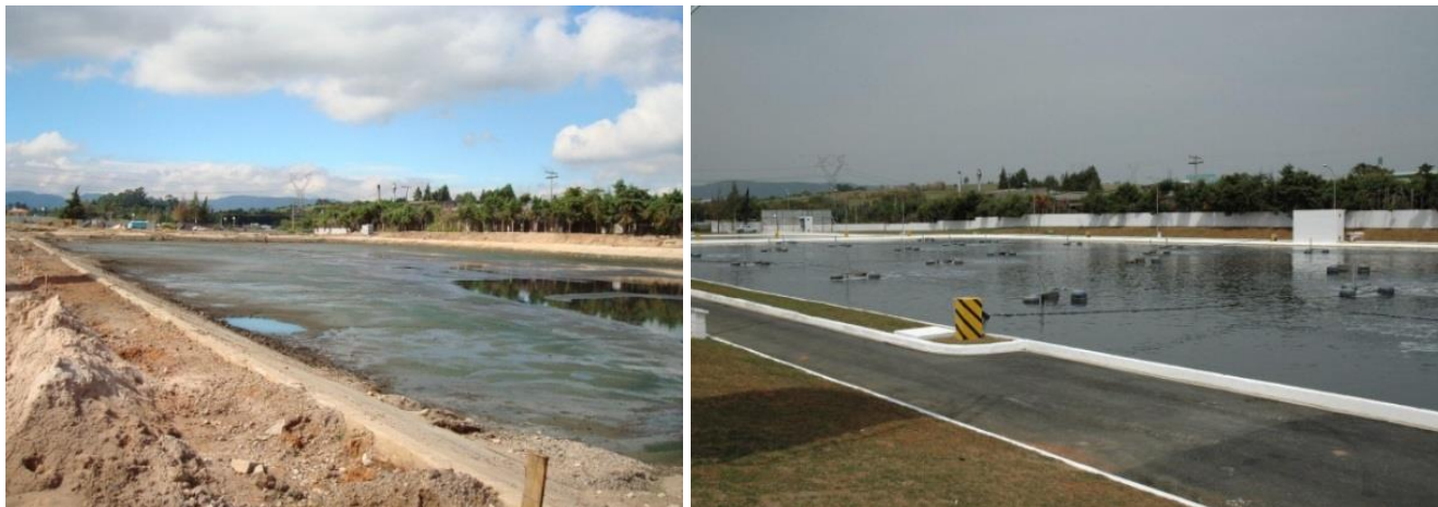
Figura 32 – Ampliação da ETE do município de Cabreúva/SP – situação antes e depois.
