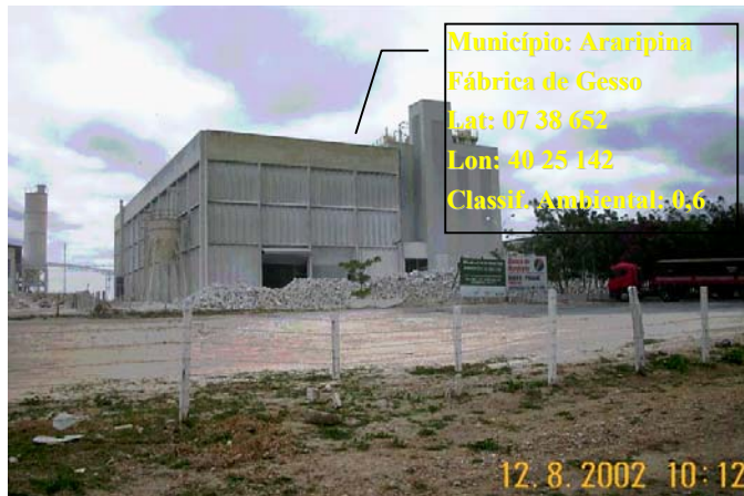
Foto 12. Fábrica de gesso visitada no município de Araripina (PE) e sua respectiva classificação ambiental.
