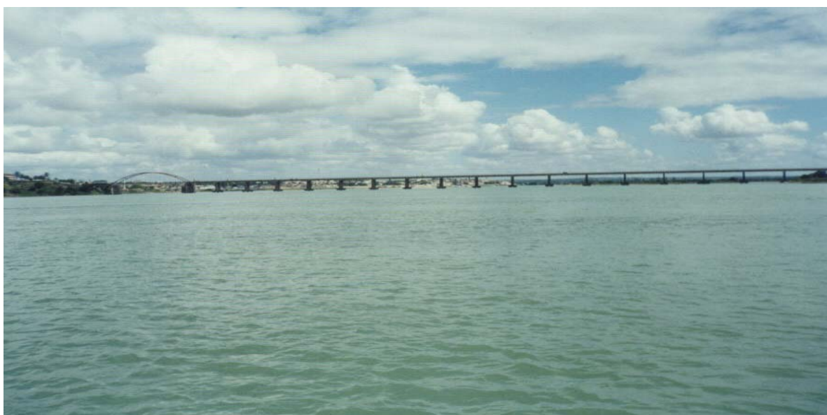
Foto 3. Ponte rodoviária em entre Própria (SE) e Porto Real do Colégio (AL).
