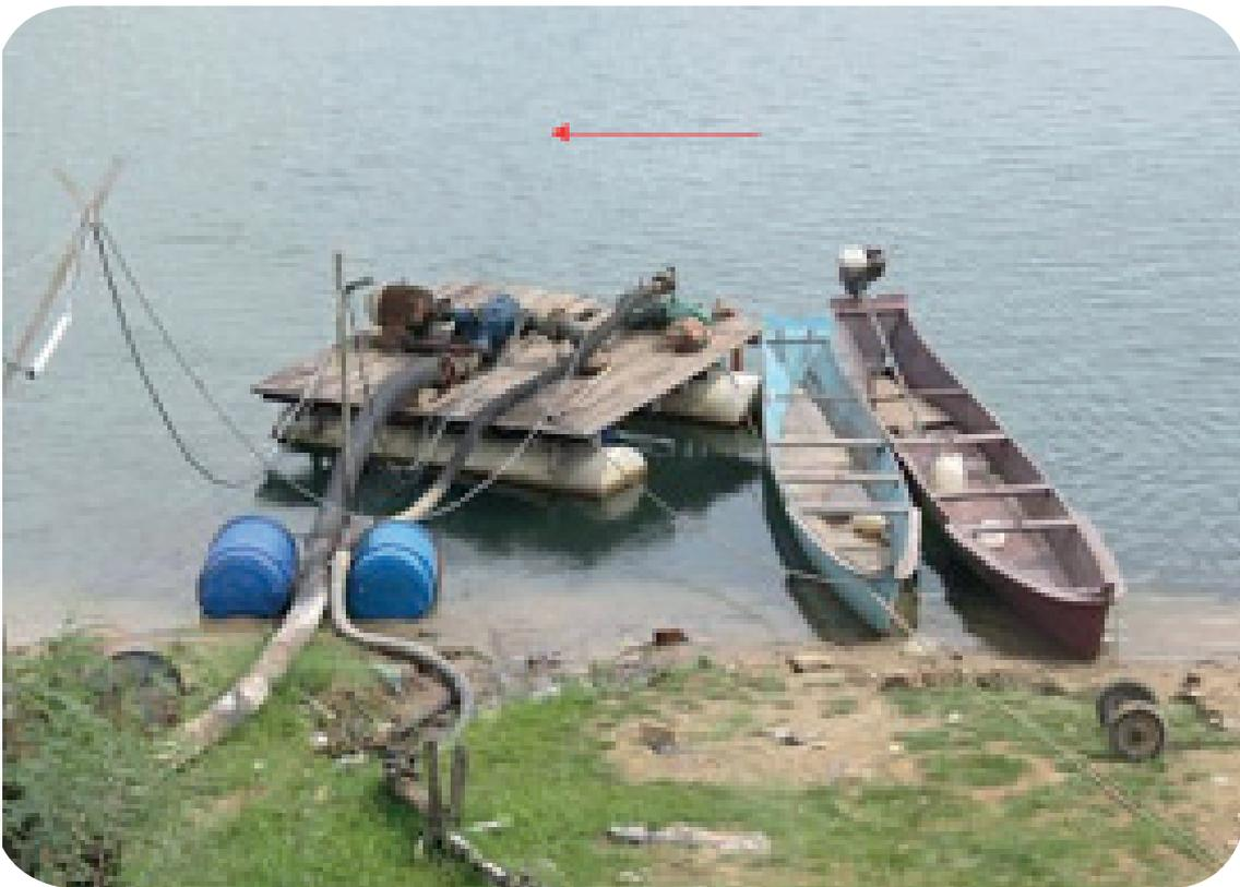
**Figura 22 - Captação flutuante de Porto Real-AL. Fonte: Chesf, 2013**
