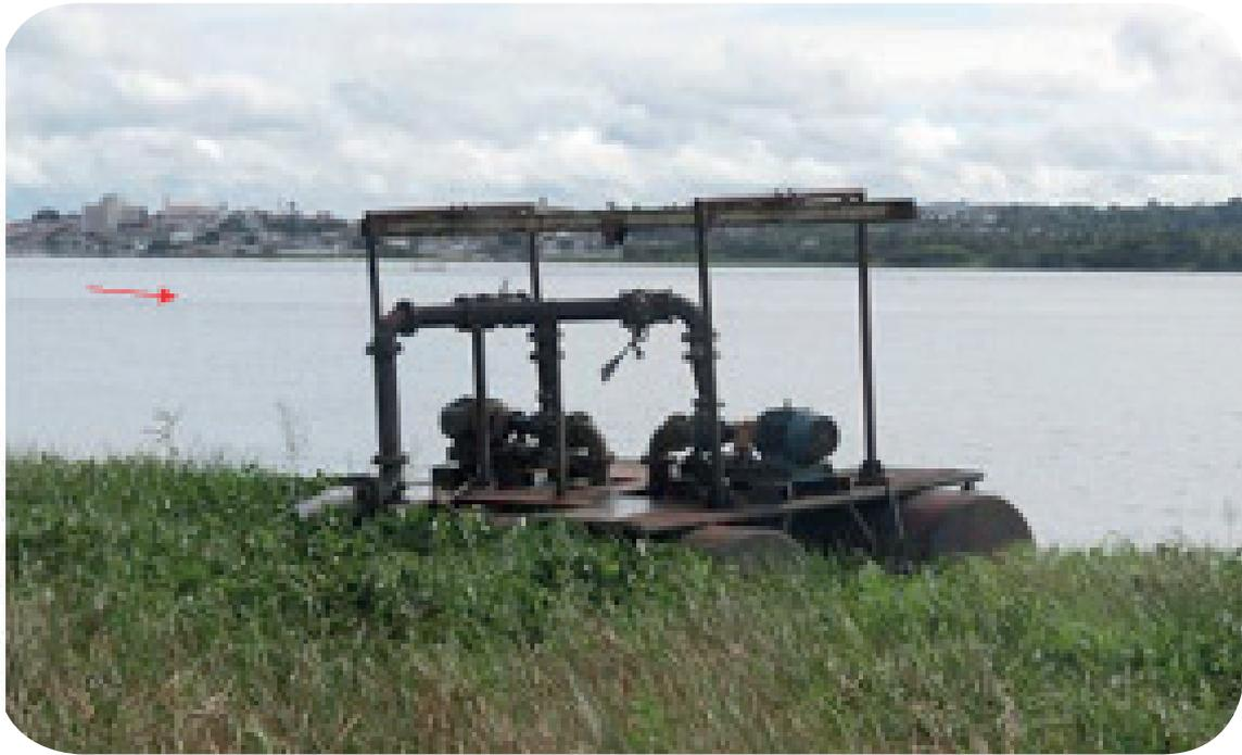
Figura 27 - Captação flutuante do Neópolis. Fonte: Chesf, 2013
