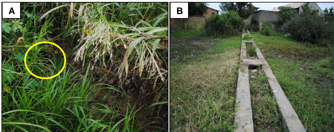
Figura 6.154 – Falta de manutenção e limpeza do sistema de drenagem. Fonte: DRZ Geotecnologia e Consultoria (2015).
