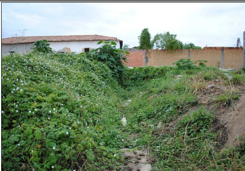
Figura 6.149 – Ladrão vazante da Lagoa 5. Fonte: DRZ Geotecnologia e Consultoria (2015).
