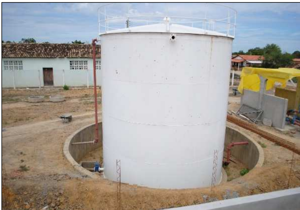
Figura 6.47 – Reservatório apoiado da ETA de Barra do Parateca. Fonte: DRZ Geotecnologia e Consultoria (2015).
