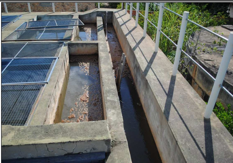
Figura 6.16 – Decantadores da ETA. Fonte: DRZ Geotecnologia e Consultoria (2015).
