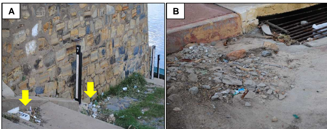
Figura 6.155 – Resíduos sólidos dispostos de forma irregular. Fonte: DRZ Geotecnologia e Consultoria (2015).
