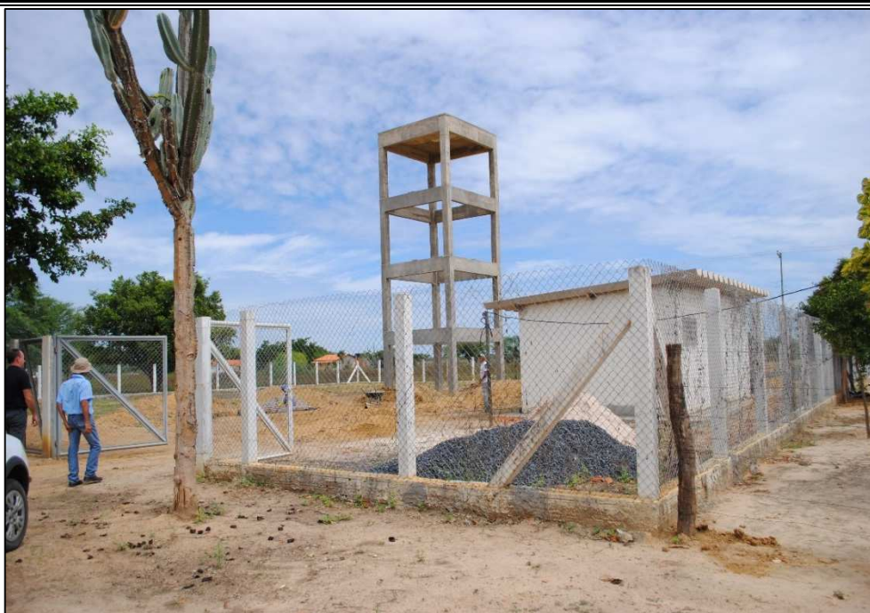
Figura 6.40 – Sistema de abastecimento de água de Três Ilhas. Fonte: DRZ Geotecnologia e Consultoria (2015).
