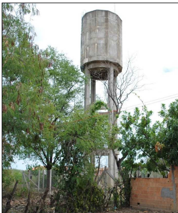
Figura 6.51 – Reservatório elevado de Barra do Parateca. Fonte: DRZ Geotecnologia e Consultoria (2015).
