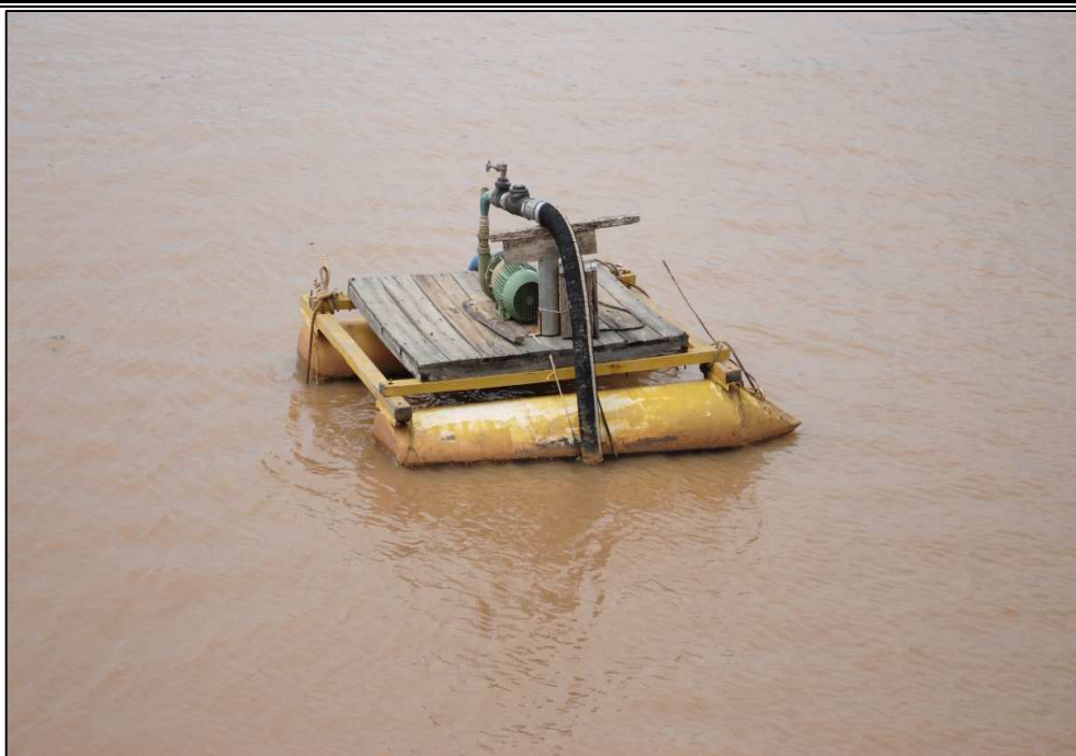
Figura 6.44 – Balsa de captação superficial de Barra do Parateca. Fonte: DRZ Geotecnologia e Consultoria (2015).
