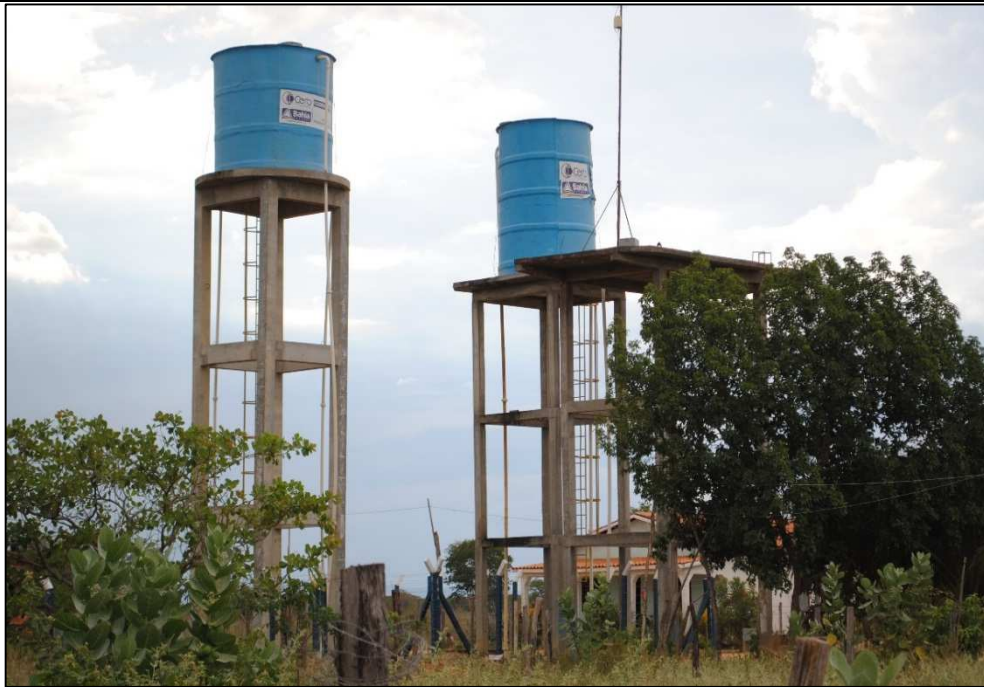
Figura 6.73 – Reservatórios elevados de Marrequeiro. Fonte: DRZ Geotecnologia e Consultoria (2015).
