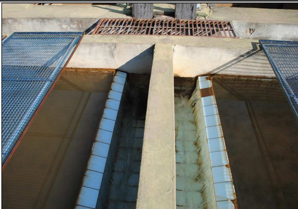
Figura 6.17 – Filtro da ETA. Fonte: DRZ Geotecnologia e Consultoria (2015).
