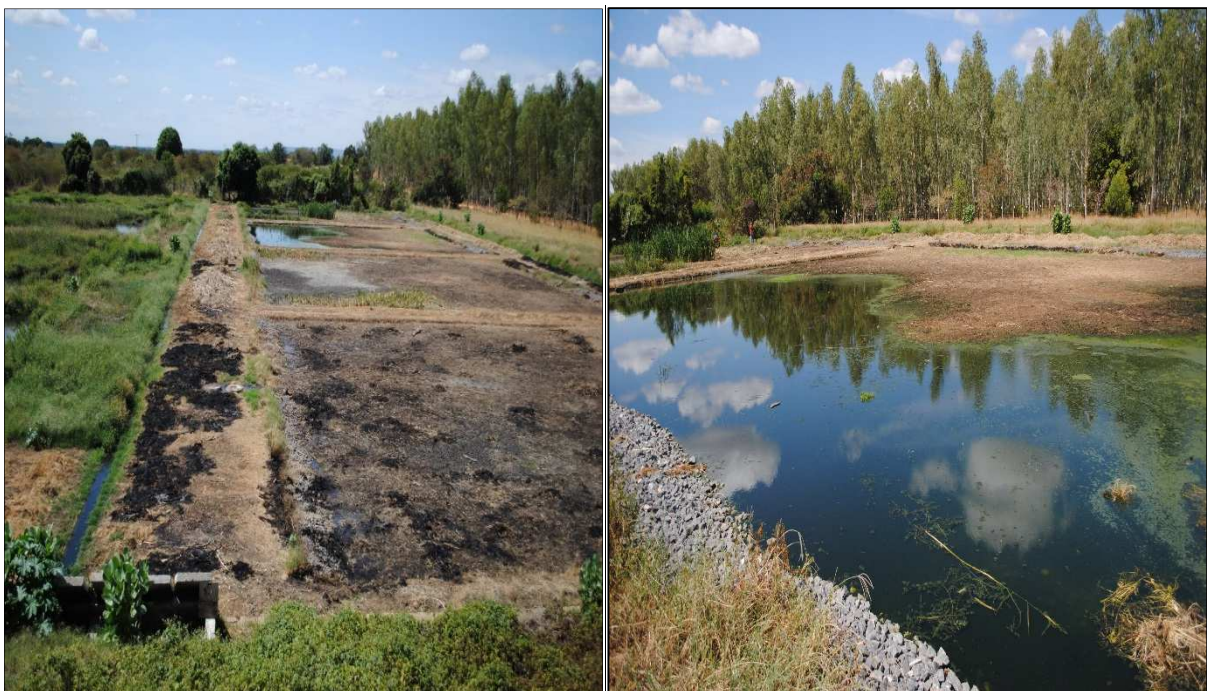
Figura 6.87 – Leitos de macrófitas ETE de Carinhanha.
