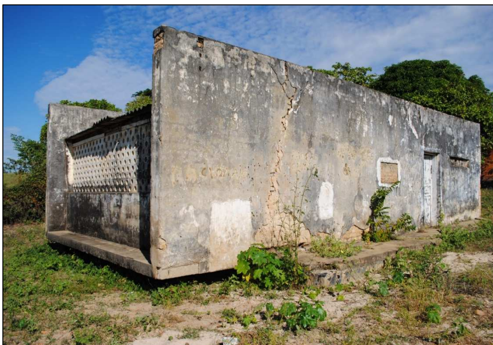
Figura 6.27 – Antigo poço de captação desativado de Carinhanha. Fonte: DRZ Geotecnologia e Consultoria (2015).
