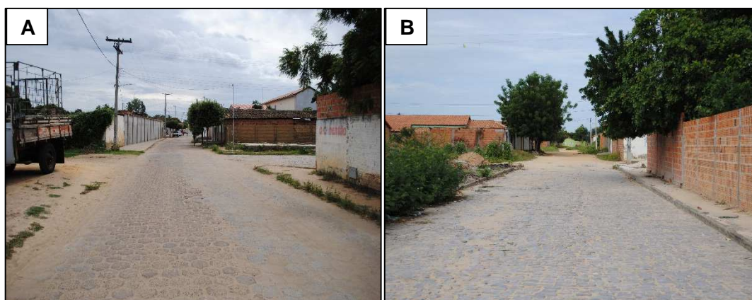
Figura 6.153 – Pavimentação de Carinhanha. Fonte: DRZ Geotecnologia e Consultoria (2015).
