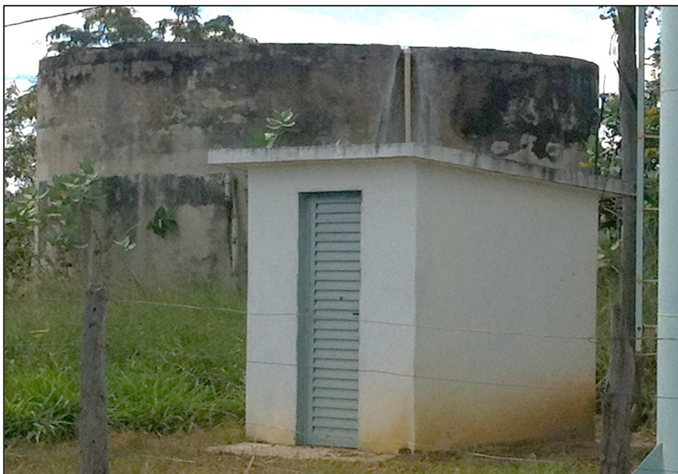
Figura 6.29 – Reservatório apoiado e casa de força de Santa Luzia. Fonte: DRZ Geotecnologia e Consultoria (2015).
