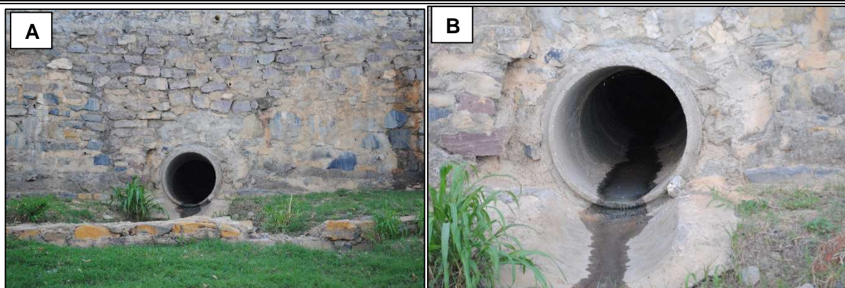
Figura 6.132 – Lançamento final de drenagem. Fonte: DRZ Geotecnologia e Consultoria (2015).
