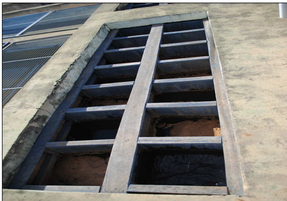
Figura 6.15 – Floculadores da ETA. Fonte: DRZ Geotecnologia e Consultoria (2015).
