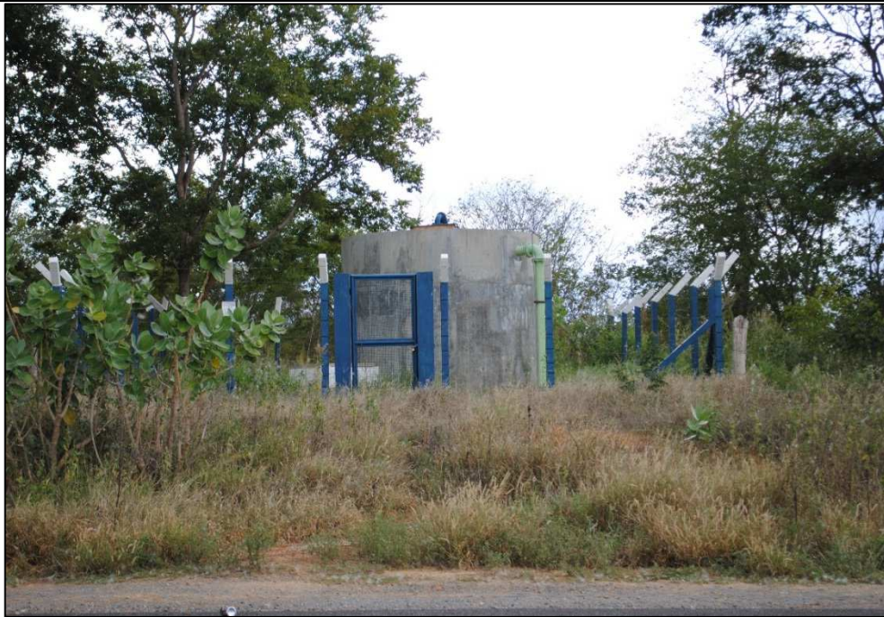
Figura 6.74 – Reservatório apoiado de Morrinho. Fonte: DRZ Geotecnologia e Consultoria (2015).
