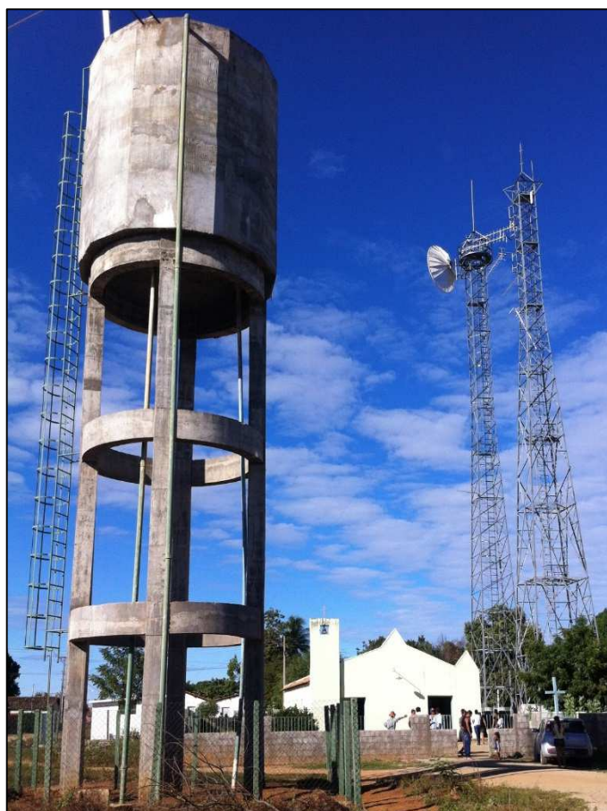
Figura 6.34 – Reservatório elevado de Barrinha. Fonte: DRZ Geotecnologia e Consultoria (2015).
