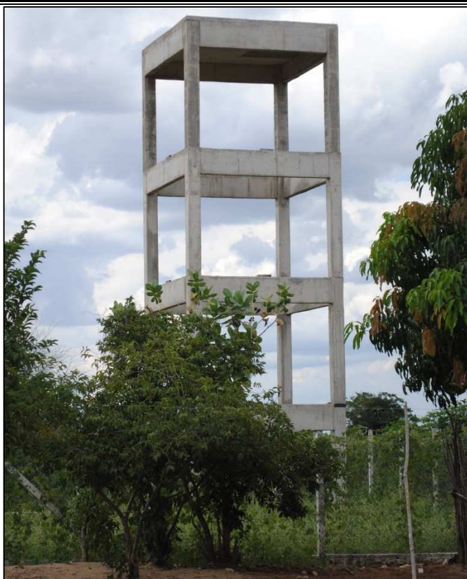
Figura 6.37 – Estrutura do reservatório elevado de Queimadas. Fonte: DRZ Geotecnologia e Consultoria (2015).
