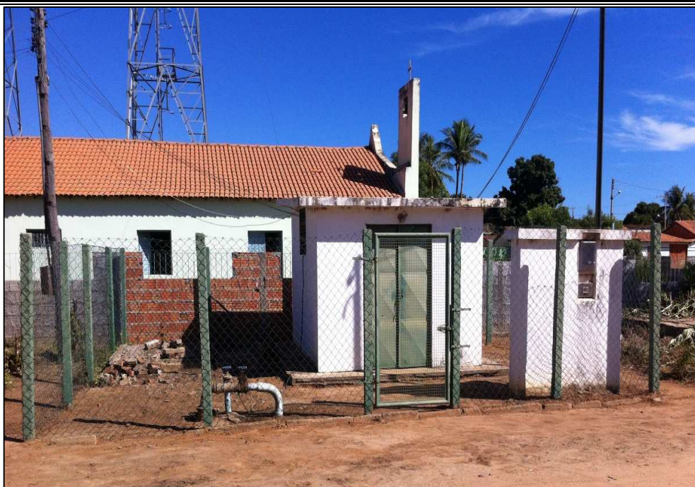
Figura 6.33 – Poço de captação e casa de força de Barrinha. Fonte: DRZ Geotecnologia e Consultoria (2015).
