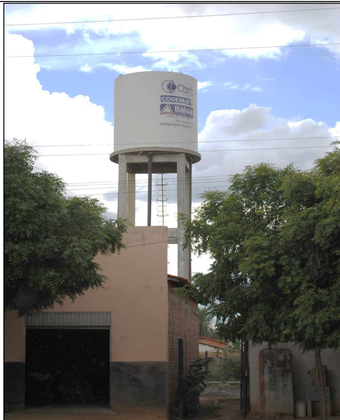
Figura 6.75 – Reservatório elevado da Vila São João. Fonte: DRZ Geotecnologia e Consultoria (2015).
