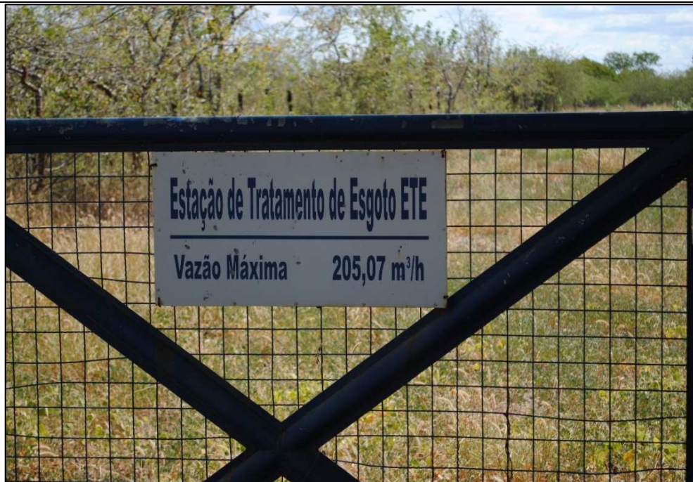
Figura 6.83 – Estação de tratamento de esgoto.
