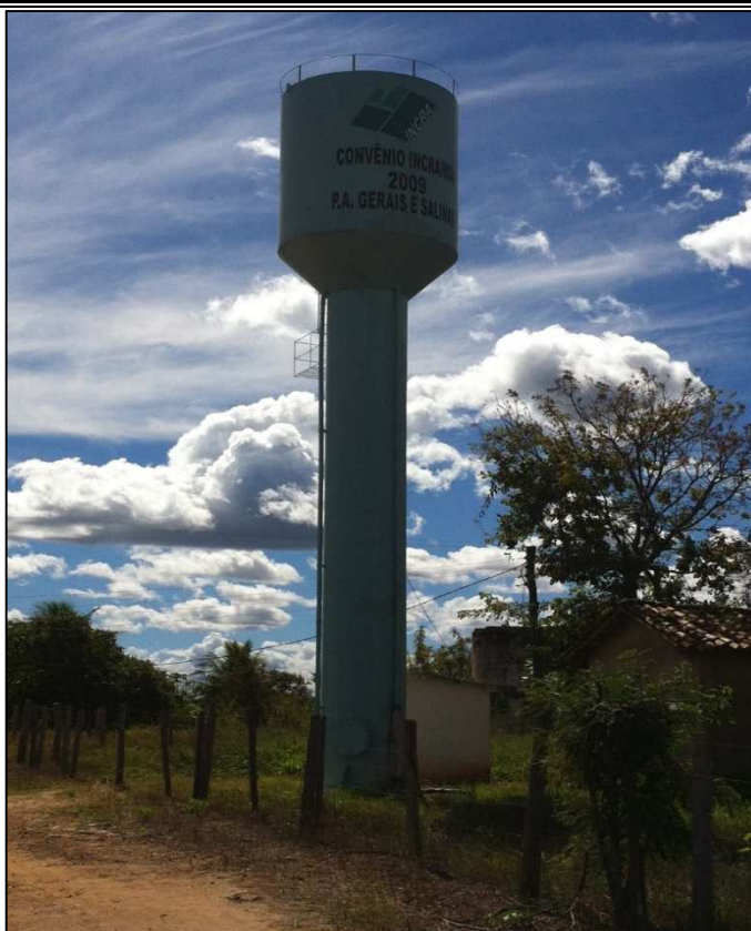
Figura 6.30 – Reservatório elevado do povoado de Santa Luzia. Fonte: DRZ Geotecnologia e Consultoria (2015).
