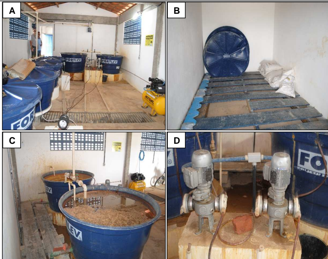
Figura 6.59 – Casa de química. Fonte: DRZ Geotecnologia e Consultoria (2015).
