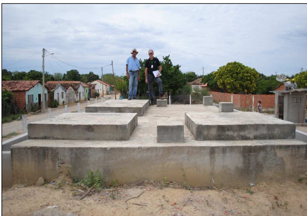
Figura 6.46 – Estação de tratamento de água de Barra do Parateca. Fonte: DRZ Geotecnologia e Consultoria (2015).
