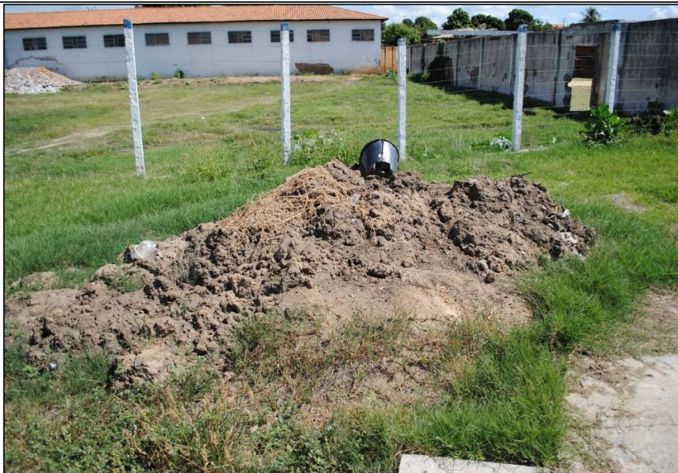
Figura 6.82 – Disposição irregular de lodo na EEE 01.
