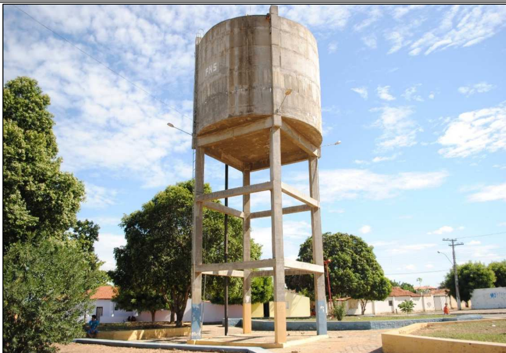
Figura 6.25 – Reservatório Alto da Colina. Fonte: DRZ Geotecnologia e Consultoria (2015).
