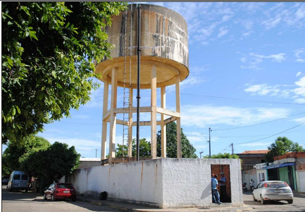
Figura 6.24 – Reservatório principal do Centro. Fonte: DRZ Geotecnologia e Consultoria (2015).
