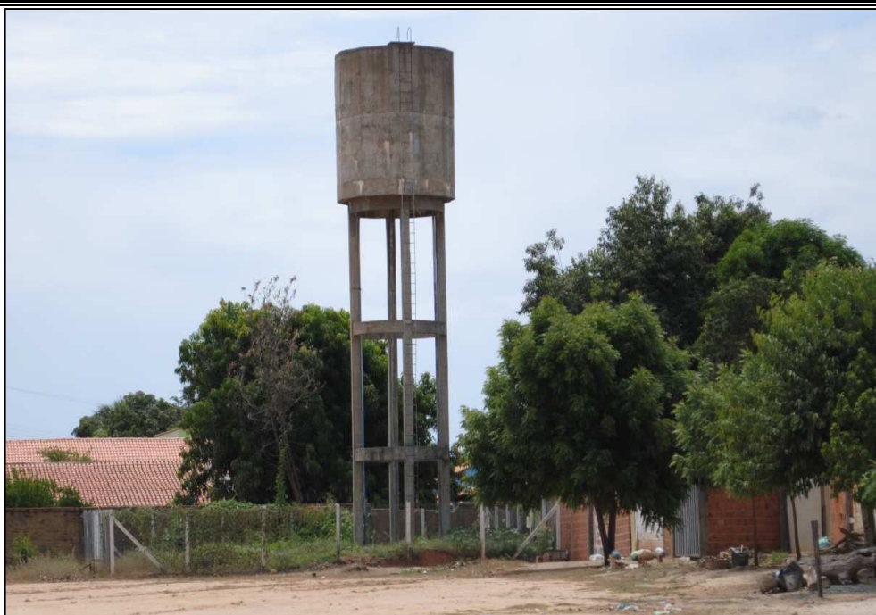
Figura 6.39 – Reservatório elevado de Angico. Fonte: DRZ Geotecnologia e Consultoria (2015).
