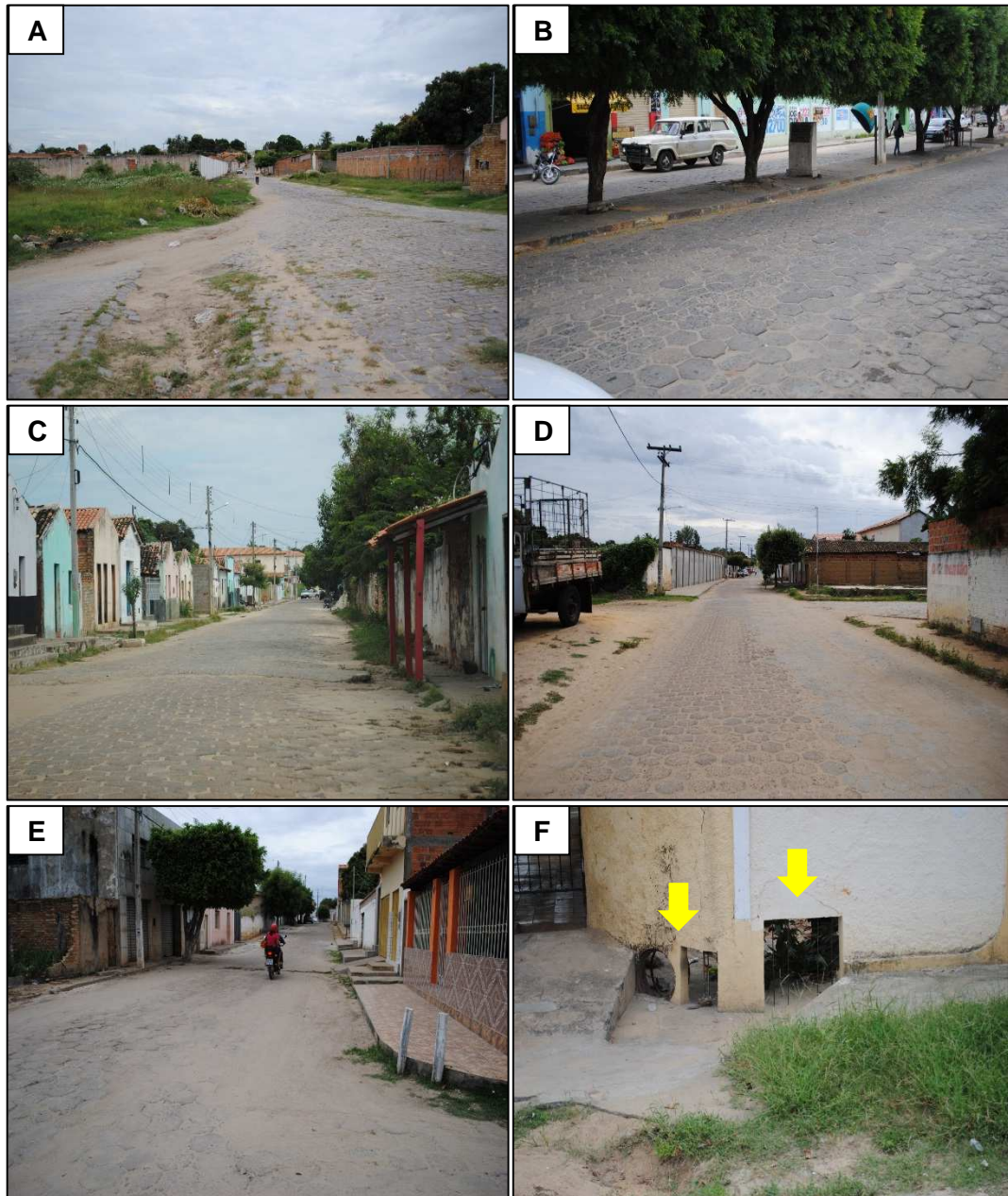
Figura 6.156 – Ruas e áreas afetadas por alagamentos em Carinhanha. Fonte: DRZ Geotecnologia e Consultoria (2015).
