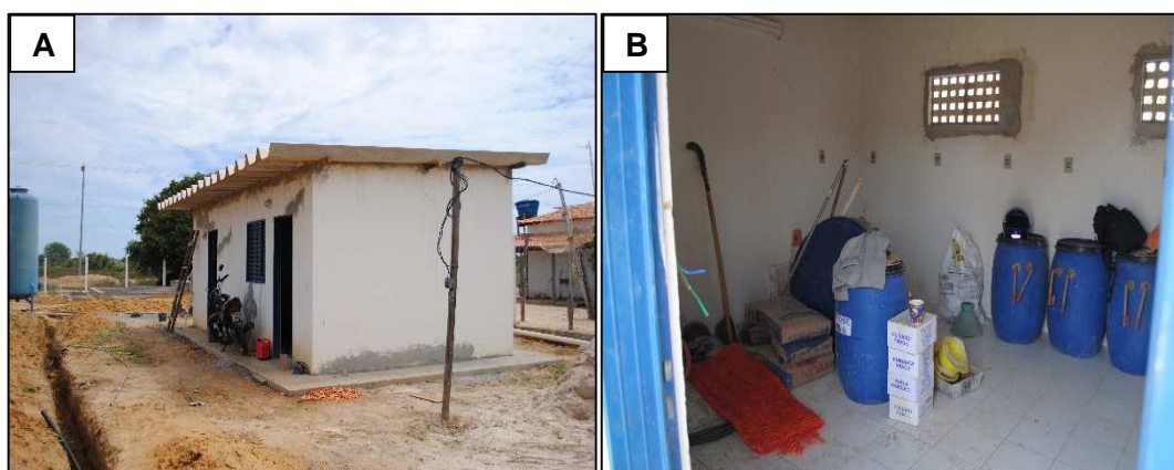
Figura 6.41 – Casa de Química. Fonte: DRZ Geotecnologia e Consultoria (2015).
