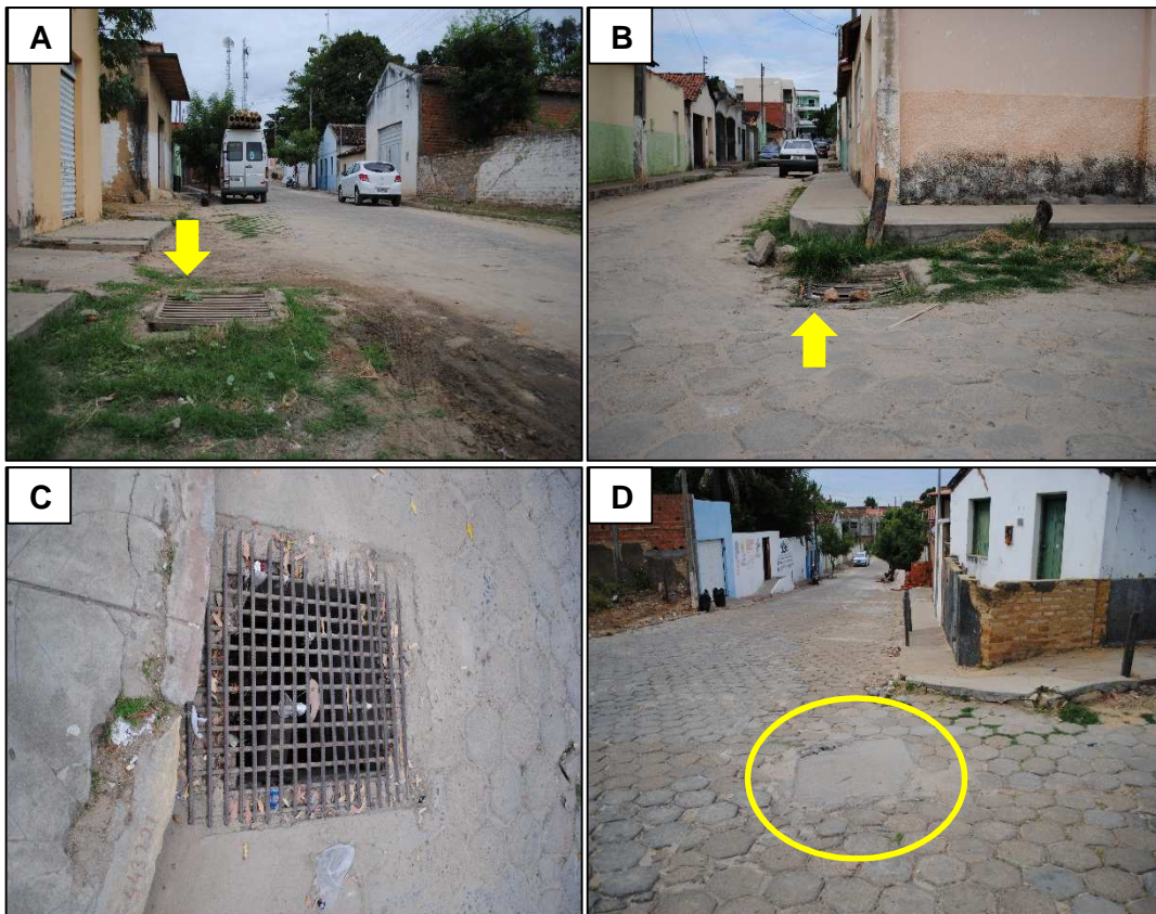
Figura 6.134 – Microdrenagem nas ruas de Carinhanha. Fonte: DRZ Geotecnologia e Consultoria (2015).
