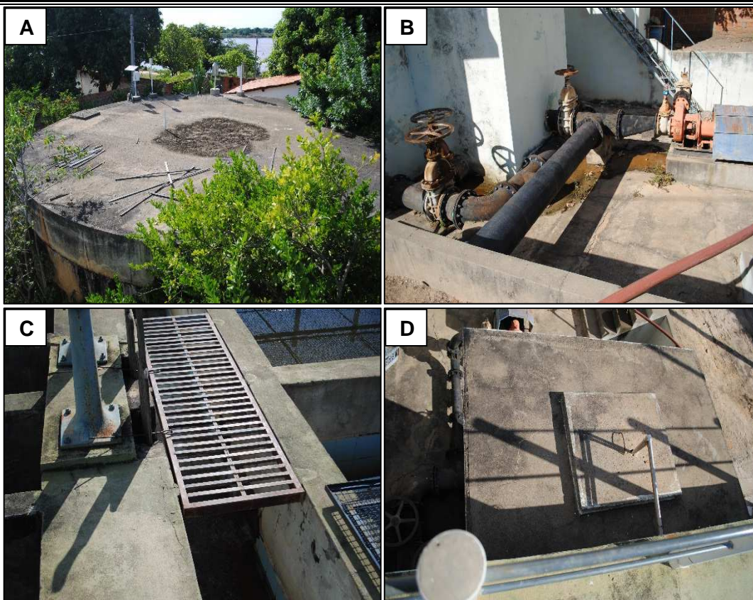
Figura 6.19 – Sistema de limpeza dos filtros Fonte: DRZ Geotecnologia e Consultoria (2015).
