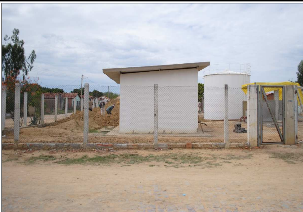
Figura 6.45 – Sistema de abastecimento de água de Barra do Parateca. Fonte: DRZ Geotecnologia e Consultoria (2015).
