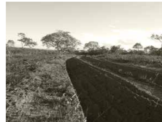
Projeto de Recuperação Hidroambiental da Bacia do Córrego da Onça Hydro-environmental Recovery Project for the Onça Creek Basin
