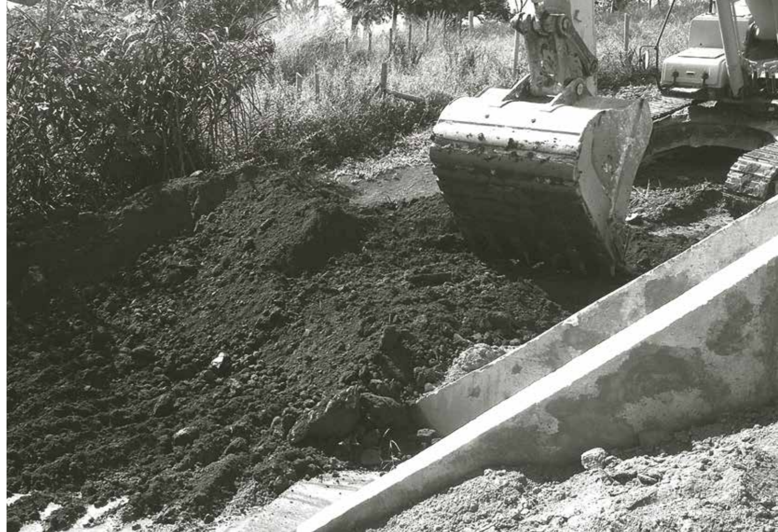
OBRA DE RECUPERAÇÃO HIDROAMBIENTAL NA BACIA HIDROGRÁFICA DO RIO BANANEIRAS
