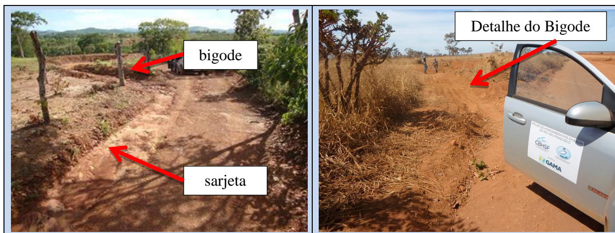
Figura 7.3 - Estradas rurais adequadas em projetos hidroambientais da bacia do rio São Francisco.
