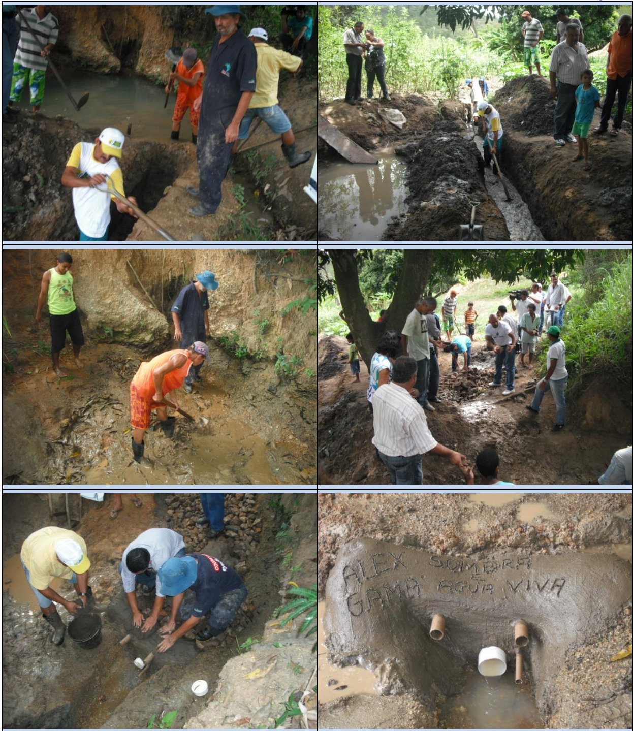
Figura 7.9 - Contenção em solocimento em nascente no Projeto “Sombra e Água Viva”.
