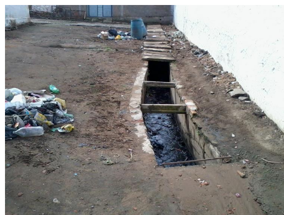
Figura 12: Lançamento de esgoto inadequado no rio São Francisco e esgoto escoando a céu aberto ao lado do cemitério municipal.
