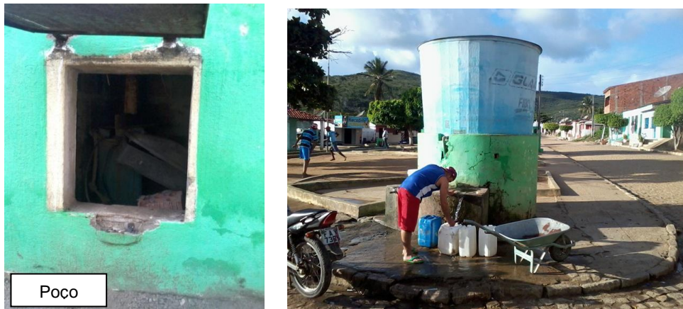
Figura 7: Fotografias do SAA, em funcionamento, da Vila Santo Antônio Fonte: Gesois, 2014.
