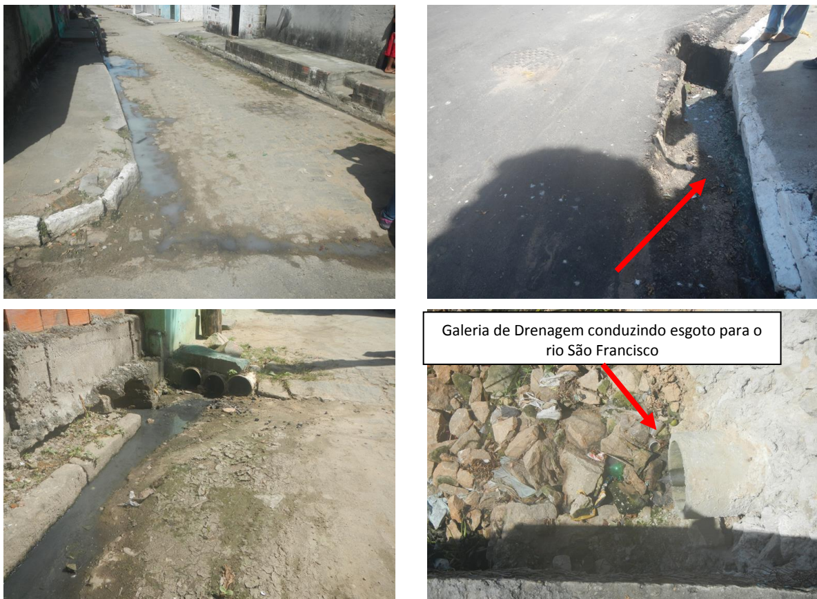
Figura 10: Lançamento de esgoto inadequado na sede municipal de Ilha das Flores. Fonte: Gesois, 2014.
