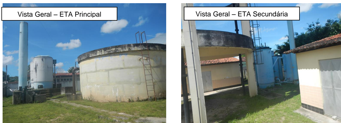
Figura 8: Estação de Tratamento de Água do Sistema de Tratamento de Água Principal e Secundário de Ilha das Flores.
