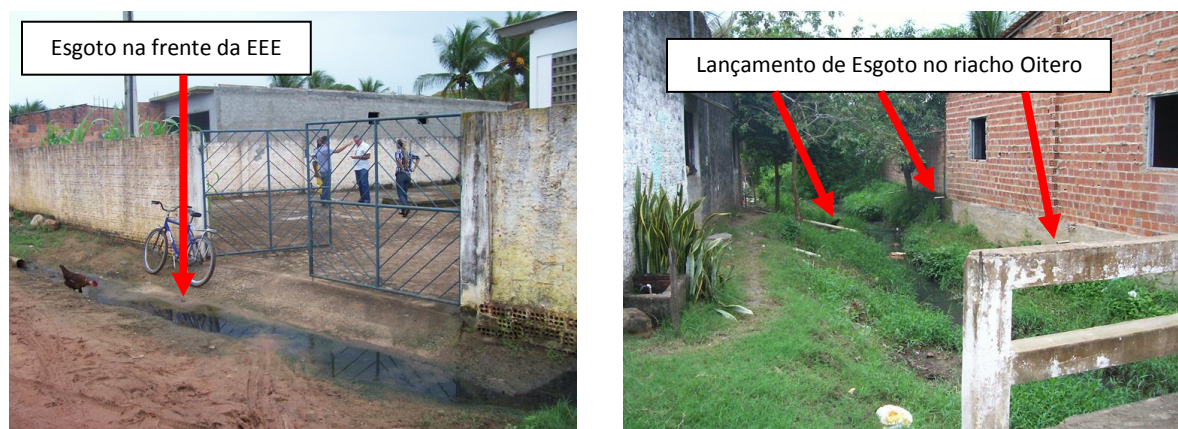
Figura 12: Lançamento de esgoto inadequado na sede municipal de Igreja Nova Fonte: Gesois, 2014.
