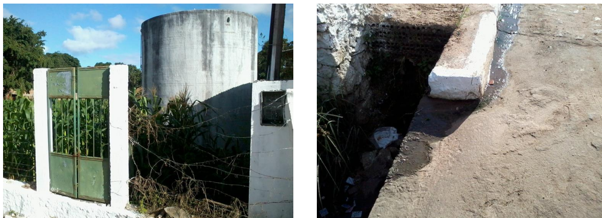
Figura 10: Possível unidade de tratamento de esgoto e esgoto a céu aberto na rua próxima. Fonte: Gesois, 2014.
