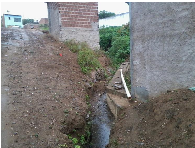
Figura 11: Escoamento de esgoto a céu aberto, na rua do Comércio e esgoto sendo lançado no afluente do rio São Francisco (riacho Porta D'água)
