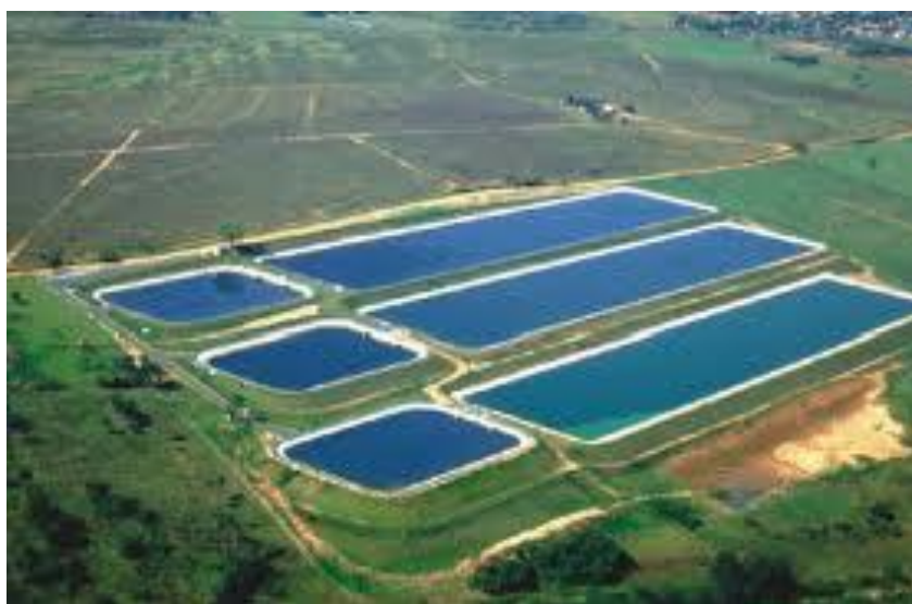
Figura 30: Lagoas de Estabilização
