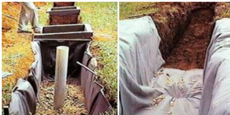
Figura 47: Exemplos de trincheira de infiltração
