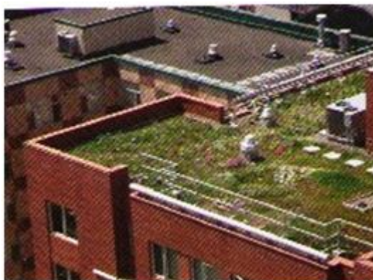
Figura 55: Telhado reservatório / telhado verde
