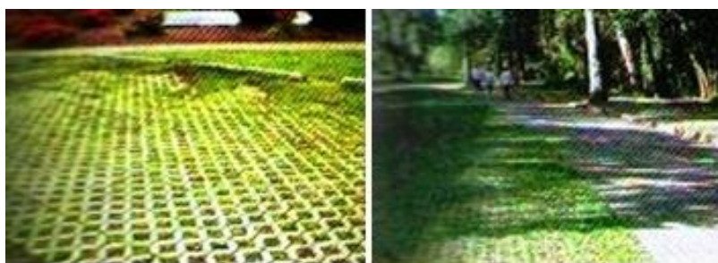
Figura 49: Pavimento poroso Parque Ibirapuera
