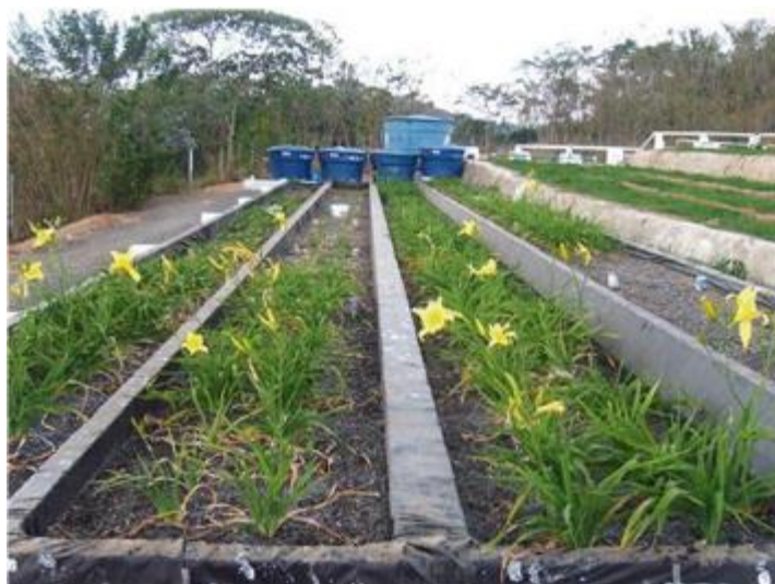
Figura 29: Tratamento de esgoto sanitário em sistemas alagados construídos cultivados com lírio amarelo
