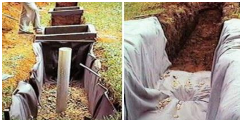
Figura 50: Exemplos de trincheira de infiltração Fonte: Collischonn, 2008
