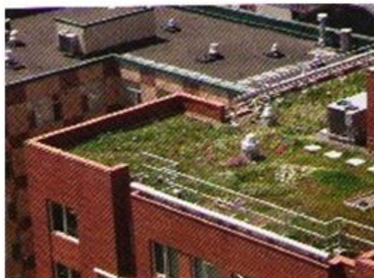
Figura 58: Telhado reservatório / telhado verde Fonte: Portland, 2002
