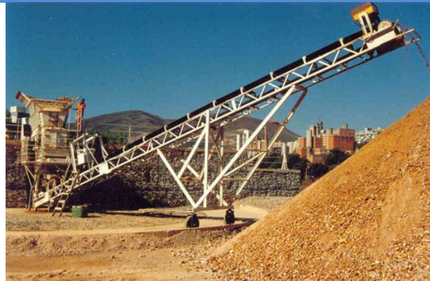
Figura 43: Usina de reciclagem de entulho da Construção Civil Fonte: SLU/CEMP, 2013
