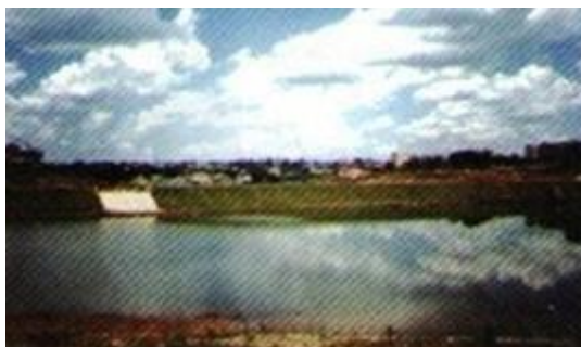
Figura 55: Bacia de detenção – N.A. permanente – Município de Uberaba Fonte: Canholi, 2005
