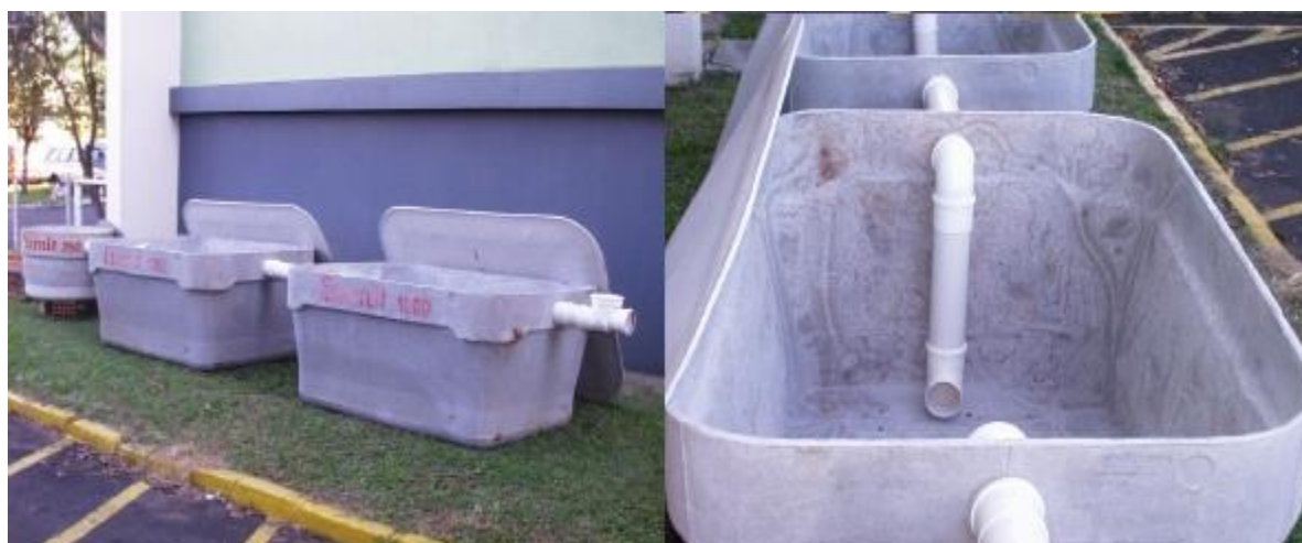
Figura 35: Biodigestor montado: vista lateral e vista superior.
