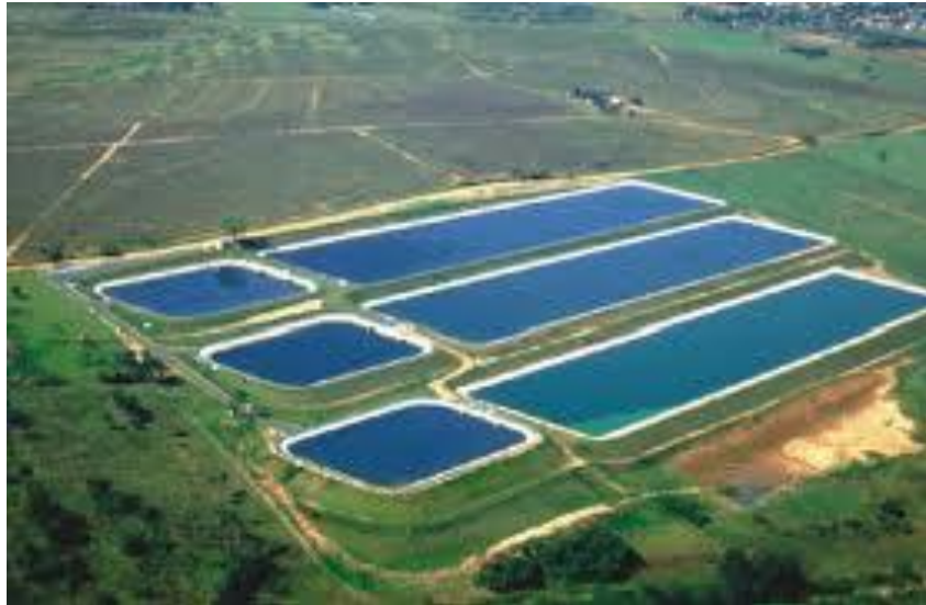
Figura 33: Lagoas de Estabilização Fonte: USP, 2014
