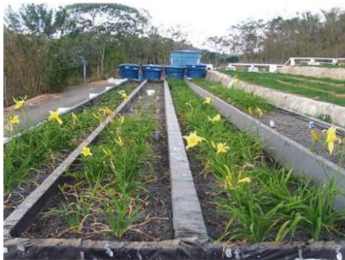
Figura 32: Tratamento de esgoto sanitário em sistemas alagados construídos cultivados com lírio amarelo Fonte: Costa et al., 2003
