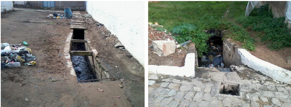
Figura 128: Esgoto escoando a céu aberto ao lado do cemitério municipal.
