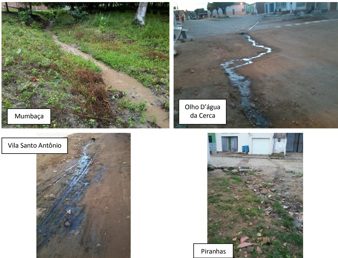
Figura 131: Lançamento de esgoto inadequado na zona rural de Traipu.
