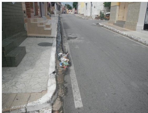
Figura 174 – Córregos e bocas de lobo no município
