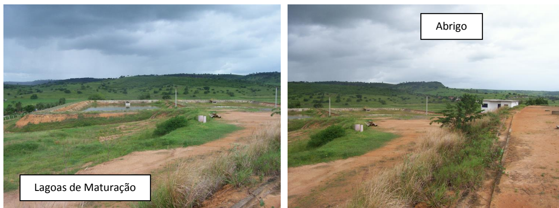
Figura 157: Estação de Tratamento de Esgoto da sede municipal Igreja Nova.
