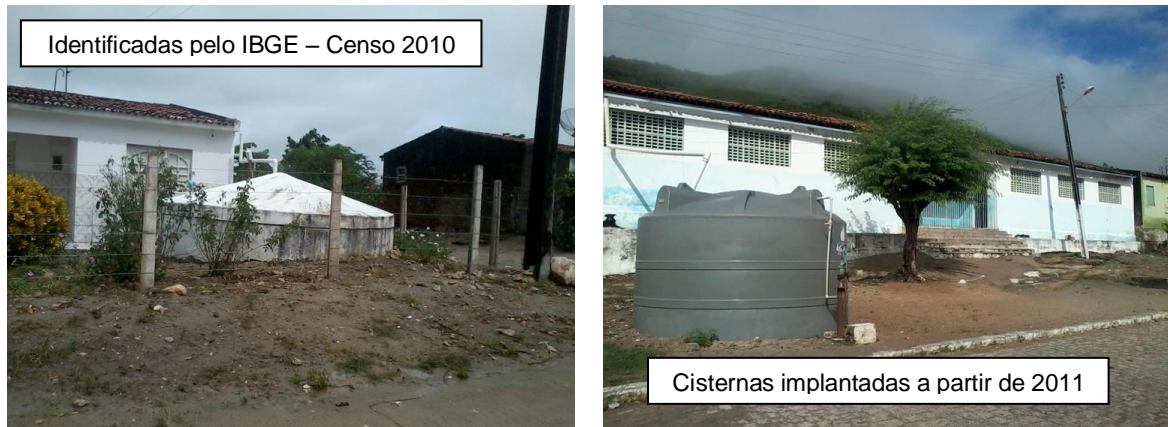
Figura 92: Cisternas de Consumo em Belo Monte.
