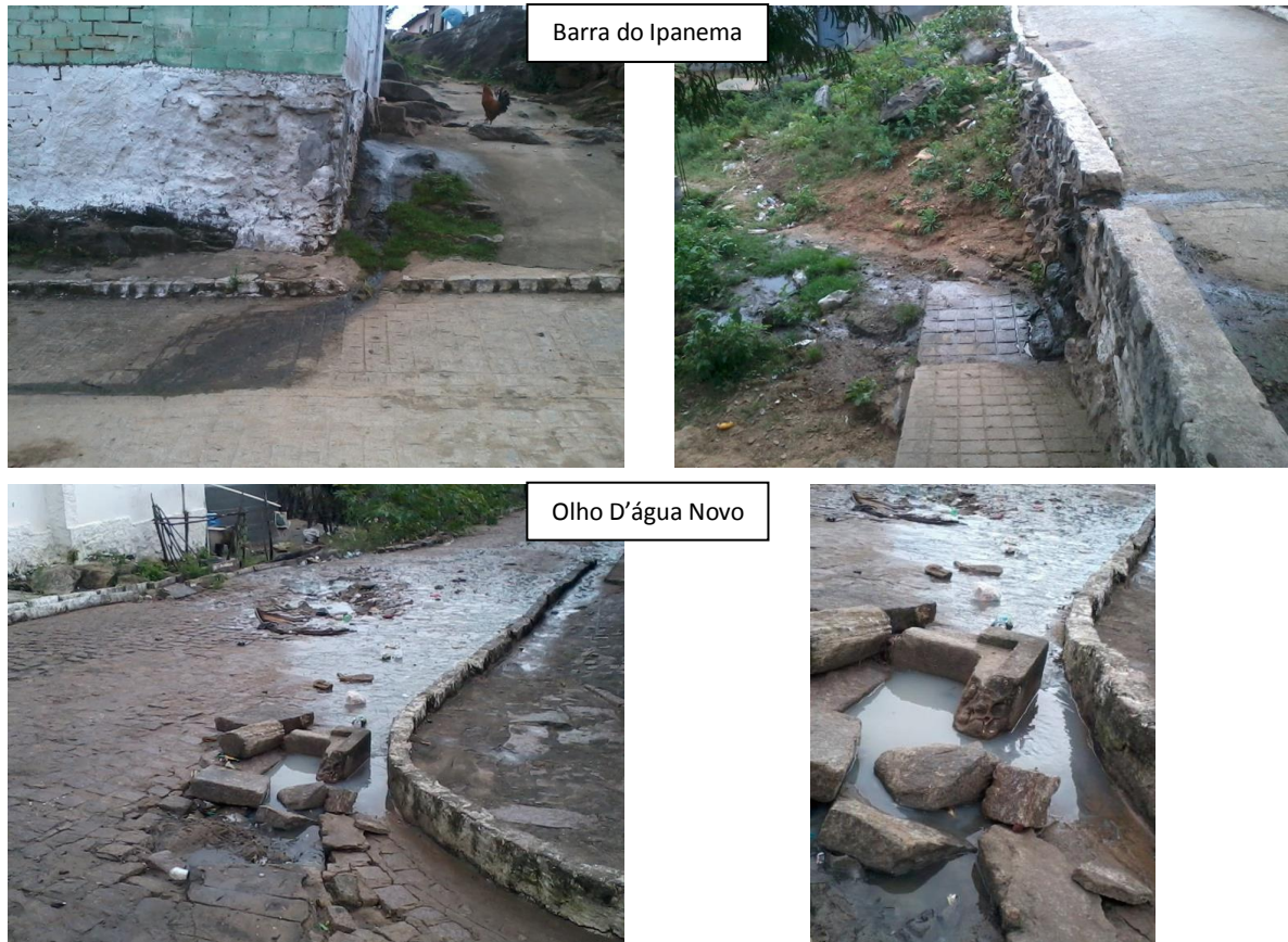
Figura 128: Lançamento de esgoto inadequado na zona rural de Belo Monte.
