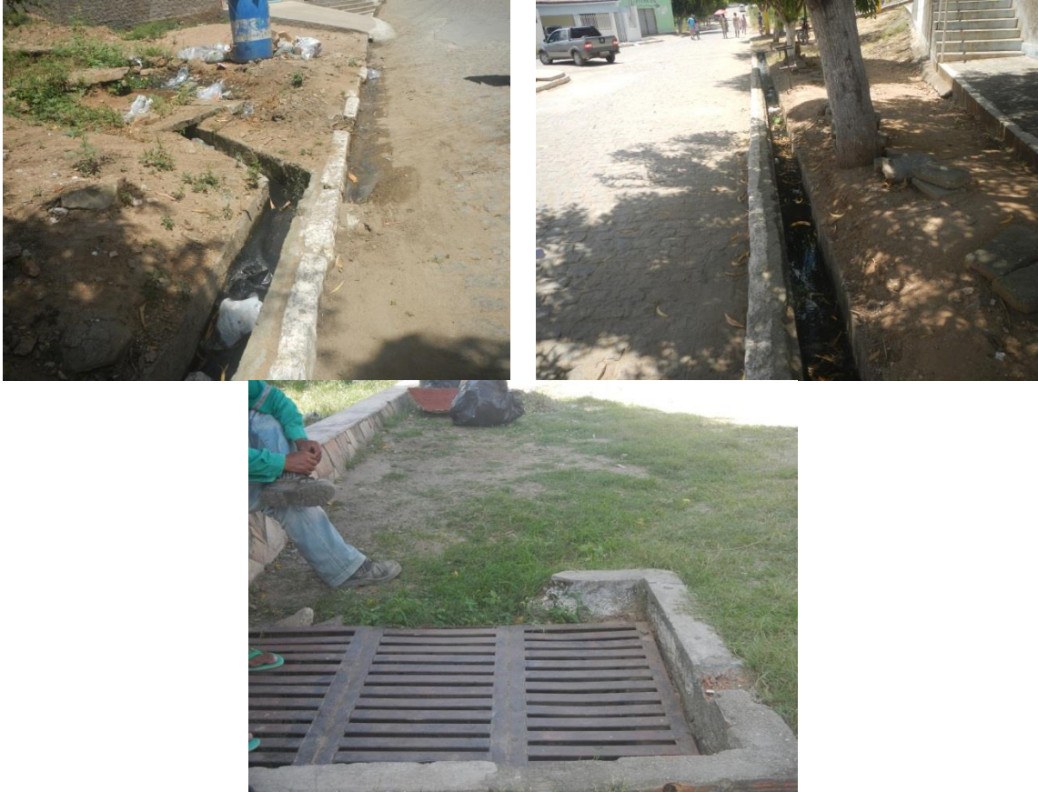
Figura 143: Córregos e bocas de lobo no município
