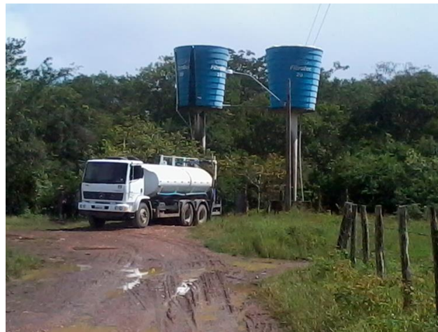
Figura 112: Infraestrutura para abastecimento da zona rural de Belo Monte por carros-pipa Fonte: Gesois, 2014.
