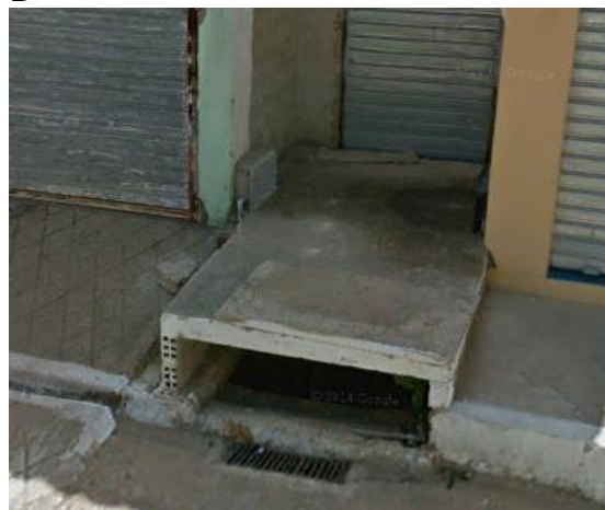
Figura 148: Bocas-de-lobo existentes no município
