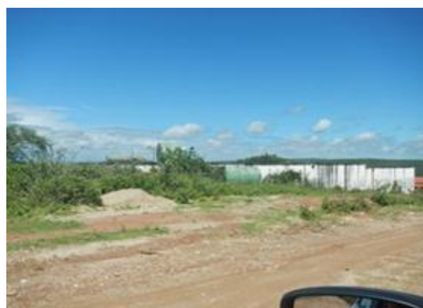
Figura 9: Reservatório desativado Fonte: Gesois, 2014
