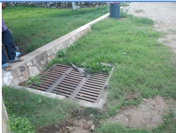
Figura 12: Drenagem em Belo Monte/AL
