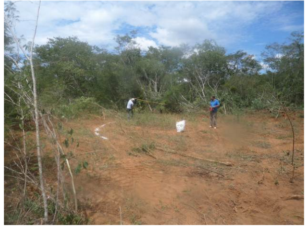
Figura 36 - Marcação limites taludes barraginha
