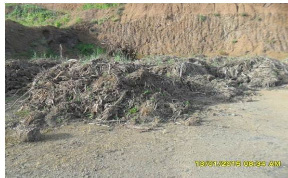
Figura 22 - Bota-fora do material retirado do rio
