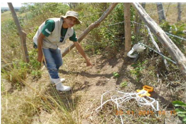
Figura 11 - Vistoria dos serviços - cerca e plantio
