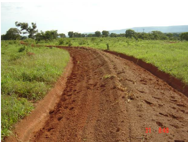
Figura 57 - Terraço construído
