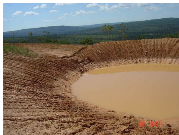
Figura 44 - Barraginha c/ detalhe da saída d'água
