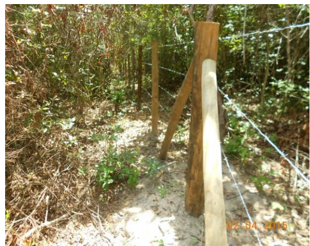
Figura 32 - Cerca - detalhe escoramento
