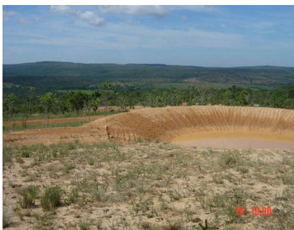
Figura 43 - Vista de barraginha - RAD
