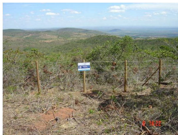
Figura 18 - Cerca instalada com placa
