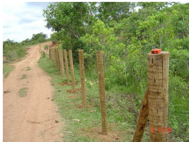
Figura 16 - Cerca - moirões instalados
