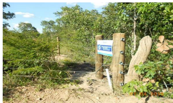
Figura 26 - Cerca - detalhe esticadores
