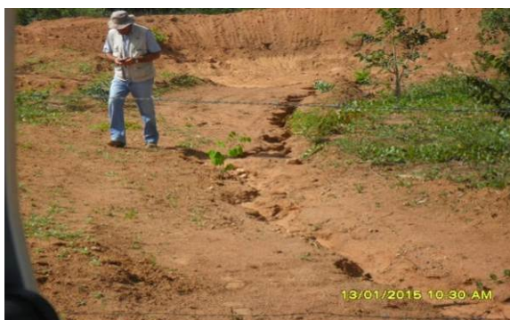
Figura 23 - Barraginha construída-entrada água
