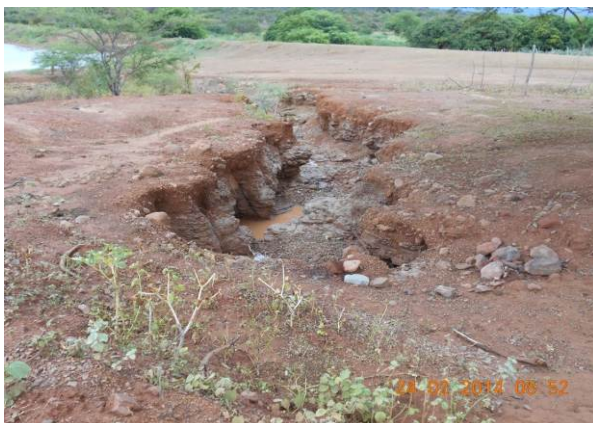
Figura 71 - Voçoroca 5 - início de contribuinte
