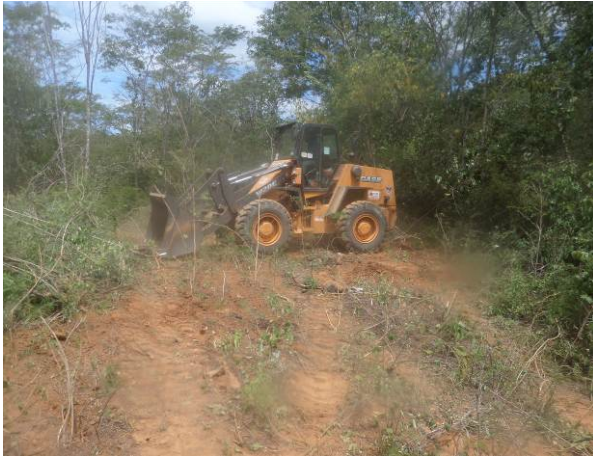
Figura 35 - Preparo terreno - construção de barraginha
