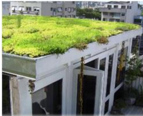
Figura 51: Exemplo de telhado verde Fonte: Ecotelhado (2013).
