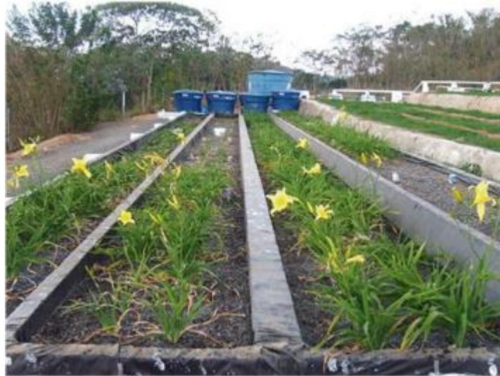
Figura 24: Tratamento de esgoto sanitário em sistemas alagados construídos cultivados com lírio amarelo
