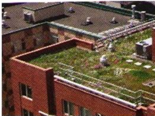
Figura 50: Telhado reservatório / telhado verde Fonte: Portland, 2002.
