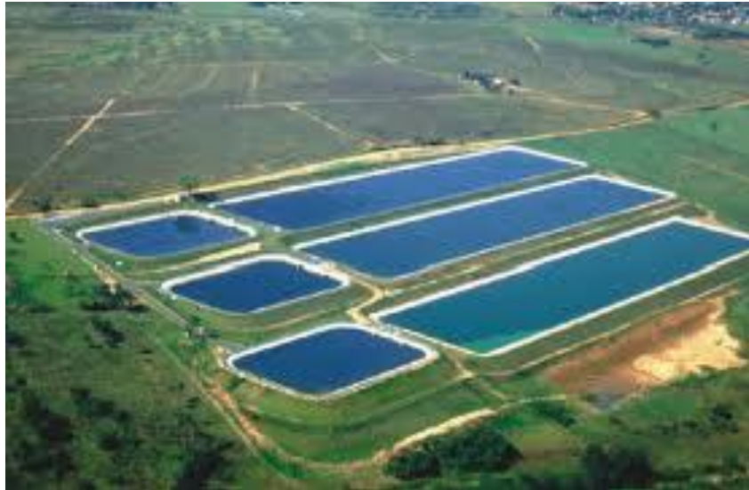
Figura 25: Lagoas de Estabilização
