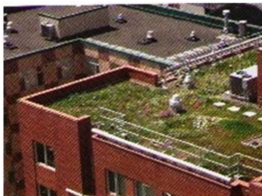
Figura 51: Telhado reservatório / telhado verde Fonte: Portland, 2002.
