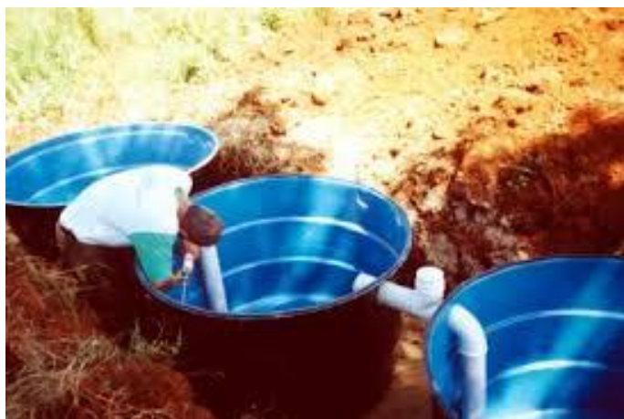
Figura 25: Fossa Séptica Fonte: Emater, 2014.
