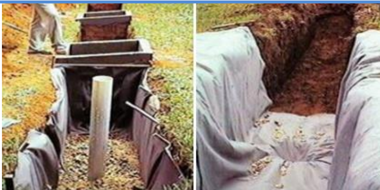
Figura 43: Exemplos de trincheira de infiltração Fonte: Collischonn, 2008.
