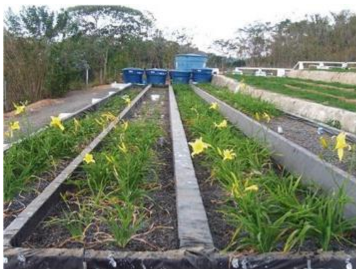
Figura 26: Tratamento de esgoto sanitário em sistemas alagados construídos cultivados com lírio amarelo Fonte: Costa et al., 2003.
