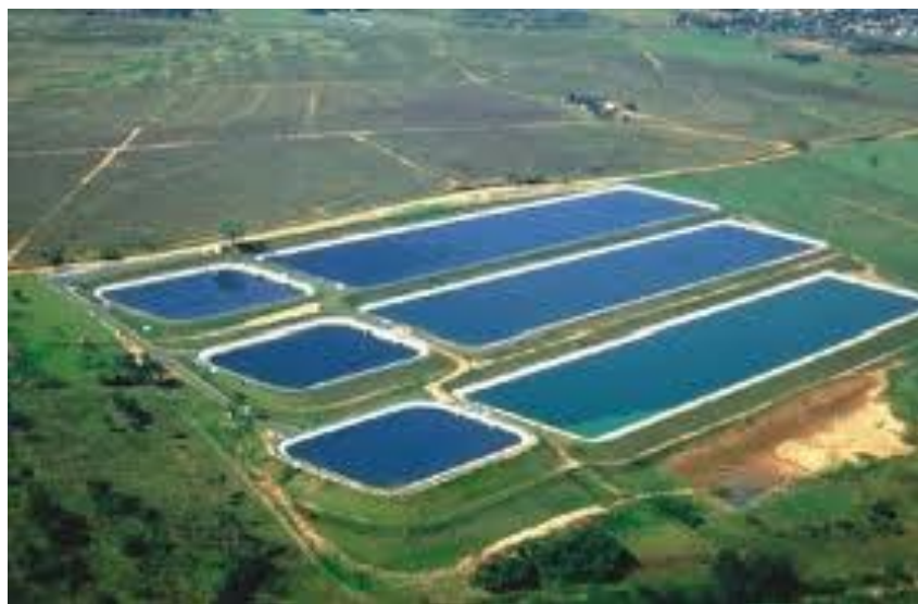
Figura 27: Lagoas de Estabilização Fonte: USP, 2014.
