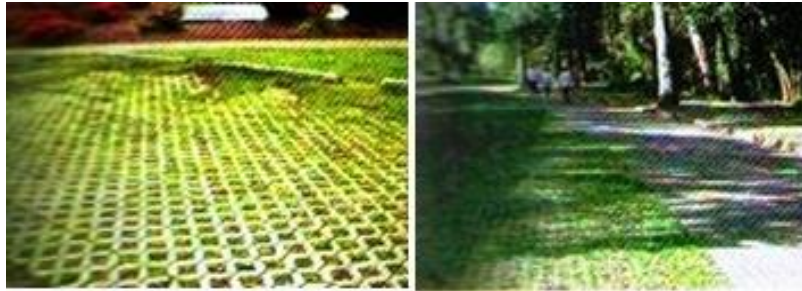
Figura 54: Pavimento poroso Parque Ibirapuera Fonte: São Paulo, 1996; Portland, 2002.
