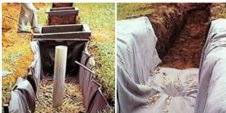
Figura 52: Exemplos de trincheira de infiltração Fonte: Collischonn, 2008.
