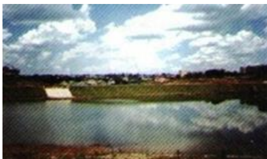
Figura 57: Bacia de detenção – N.A. permanente – Município de Uberaba Fonte: Canholi, 2005.
