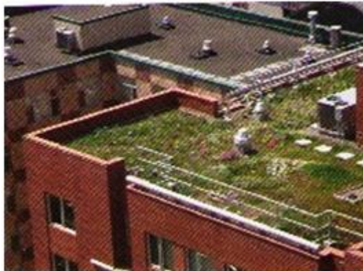
Figura 60: Telhado reservatório / telhado verde Fonte: Portland, 2002.
