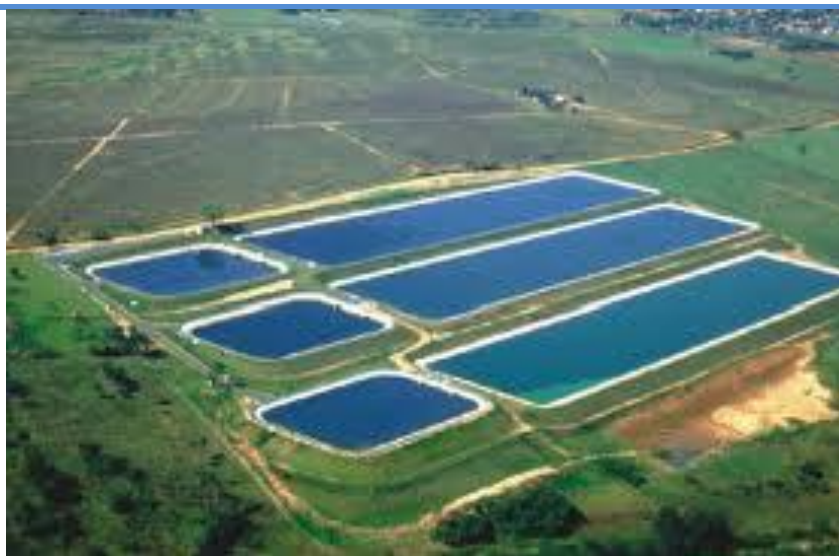
Figura 35: Lagoas de Estabilização Fonte: USP, 2014
