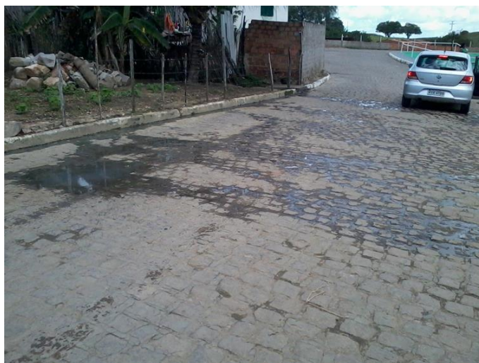
Figura 113: Lançamento de esgoto inadequado na zona rural de Telha – Povoado Bela Vista.
