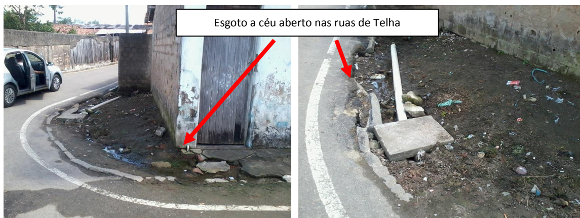
Figura 112: Lançamento de esgoto inadequado na sede municipal de Telha. Fonte: Gesois, 2014.
