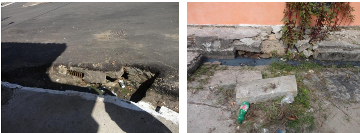
Figura 127 – Córregos e bocas de lobo no município Fonte: Gesois, 2014.
