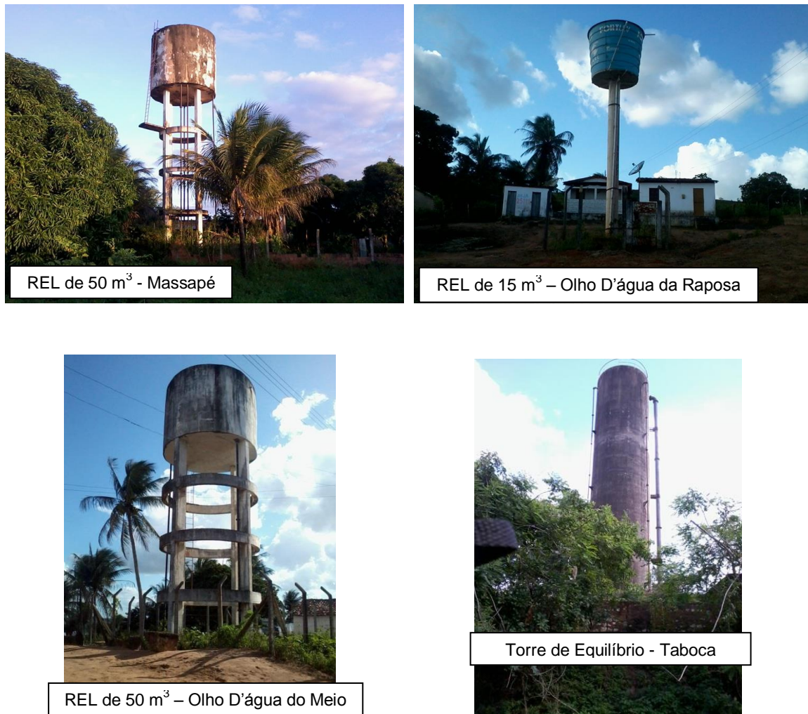
Figura 102: Reservatórios de água tratada e torre de equilíbrio pertencentes ao SAA da CASAL.
