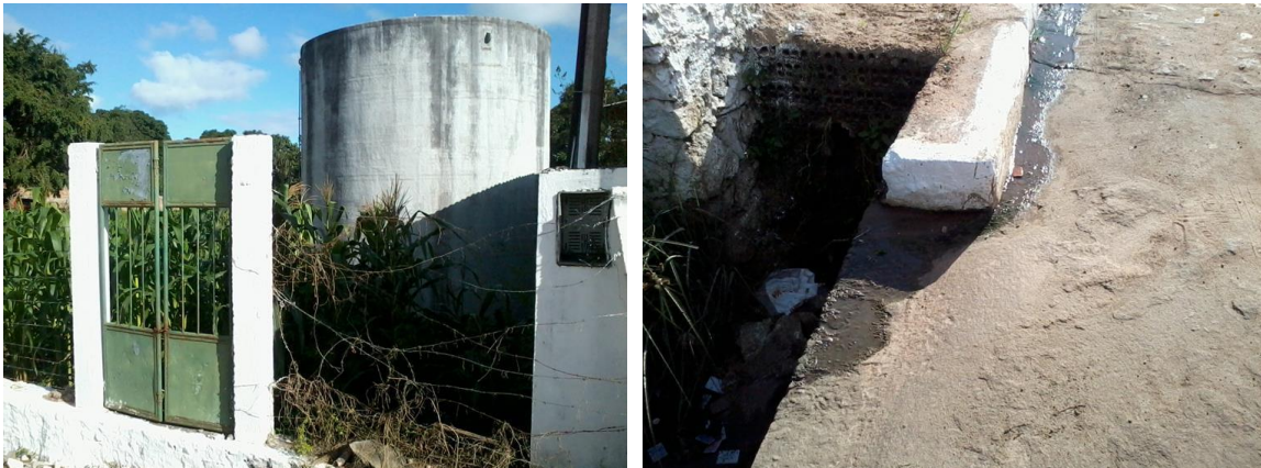
Figura 136: Possível unidade de tratamento de Esgoto e Esgoto a céu aberto na rua próximo.
