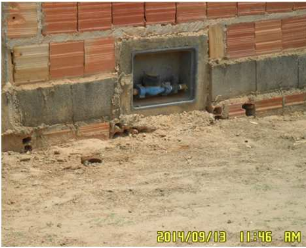
Figura 75 – micromedição - Hidrômetros
