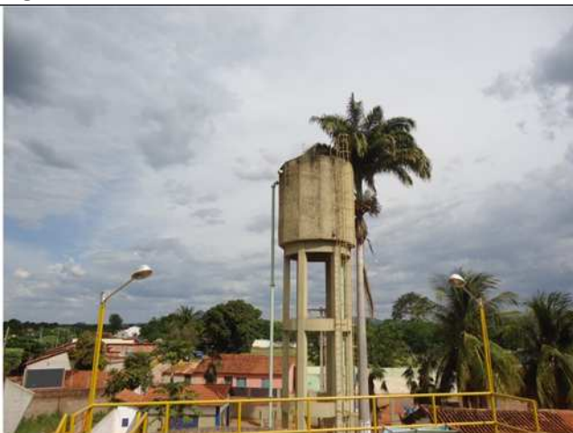
Figura 71– Reservatório de 50 m 3
