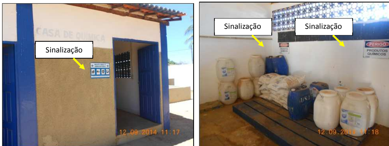
Figura 33 - Casa de química e armazenamento dos produtos químicos
