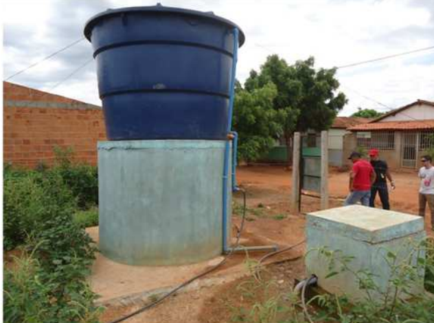
Figura 63 – vista lateral do poço
