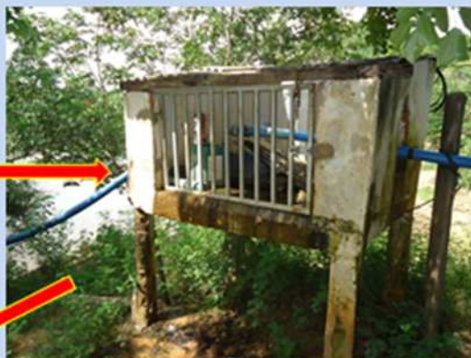
Captação superficial , casa de bomba e reservatório para abastecimento da comunidade de Santa Luzia, Sistema operado pela Prefeitura
