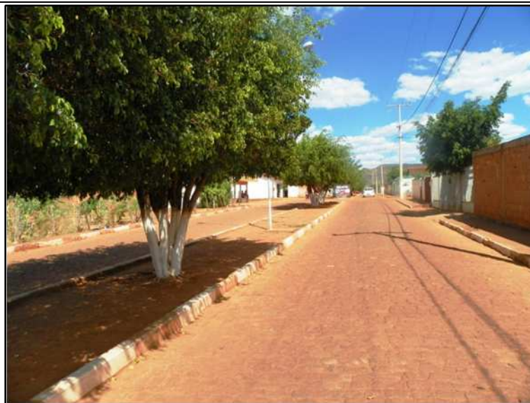
Figura 87 – Via do distrito de Aricobé que recebe serviços de varrição e pintura de meio fio
