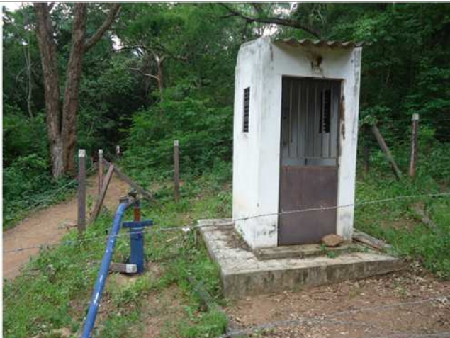
Figura 66 – vista frontal do poço
