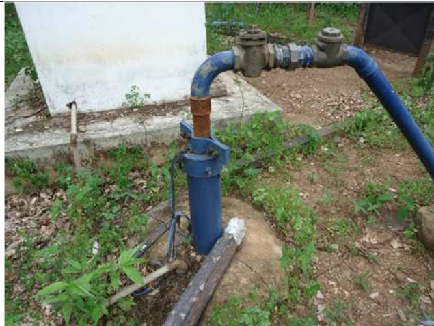
Figura 67 – vista lateral do poço
