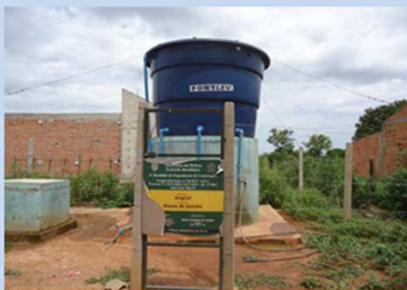
Poço 2 (próximo a quadra em construção)
