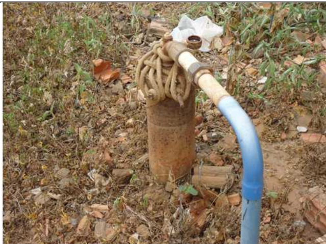
Figura 64– vista frontal do poço
