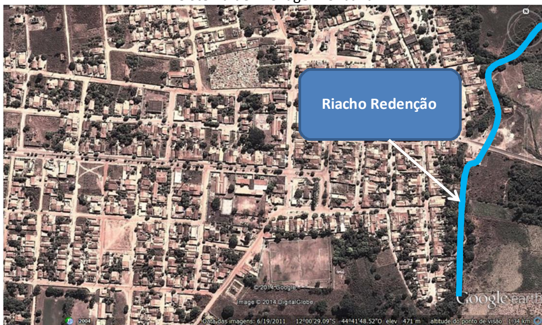
Figura 108– Visão do Sistema de Macrodrenagem Urbana Sistema de Drenagem Urbana
