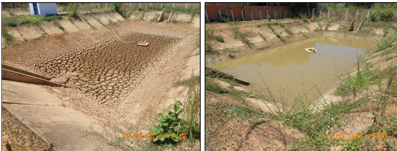
Figura 41 – Tanques de decantação e reaproveitamento
