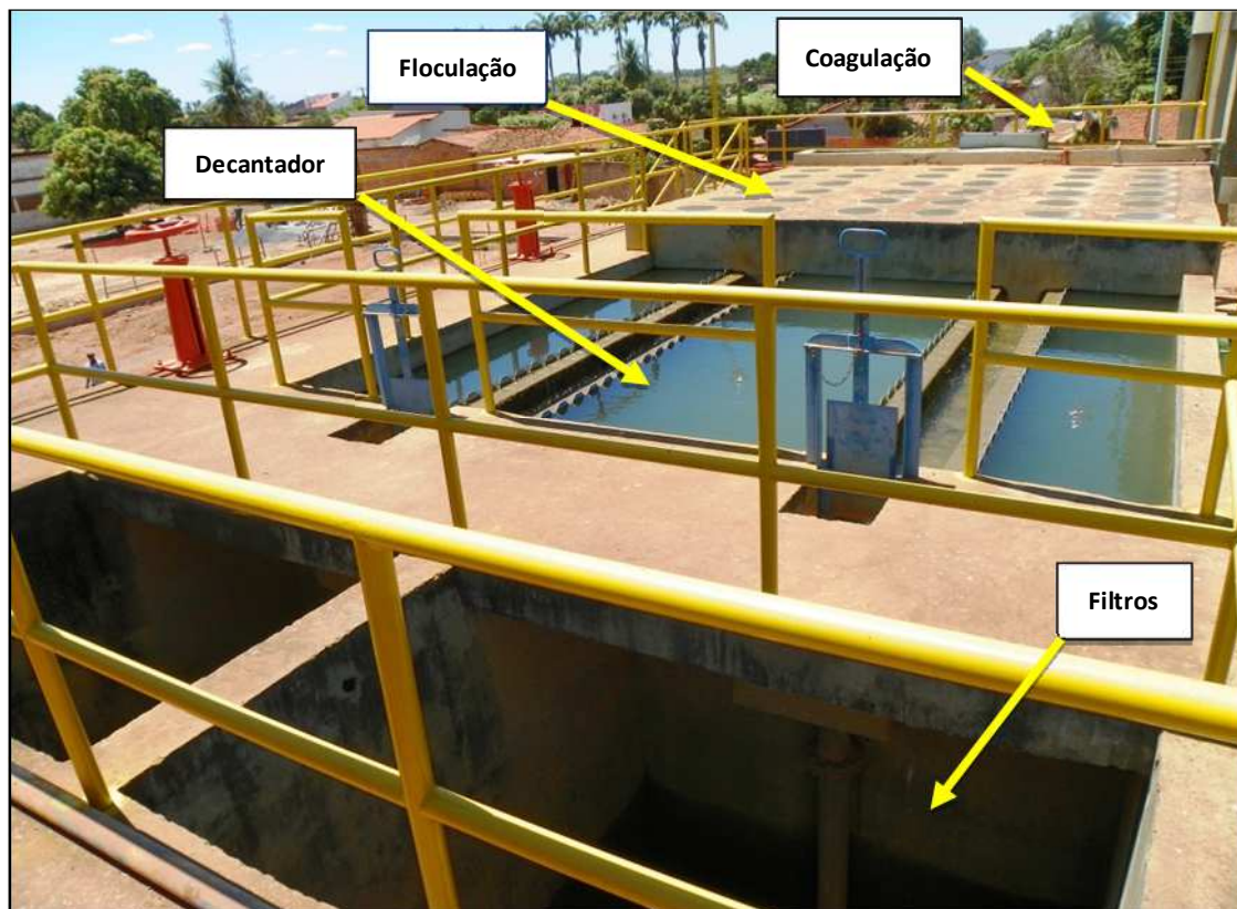
Figura 36 - Sistema Convencional da ETA
