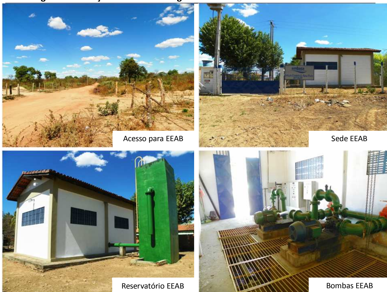
Figura 29– Estação Elevatória de Água Bruta na Comunidade de Santa Luzia
