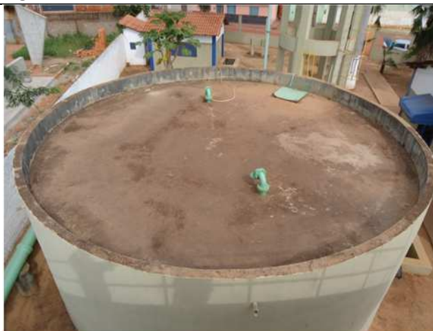
Figura 72– Reservatório de 200 m 3
