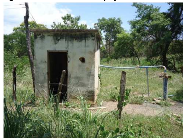
Figura 70– vista lateral do poço
