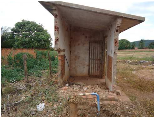
Figura 65– antiga casa de força desativada
