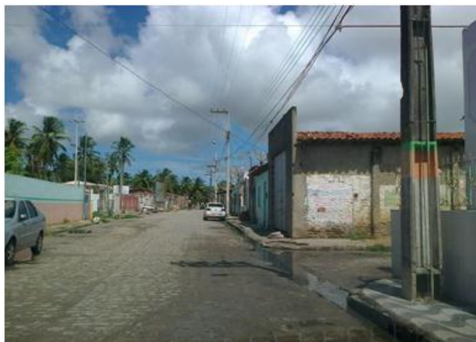
Figura 10: Esgoto em via pública em Ilha das Flores/SE.
