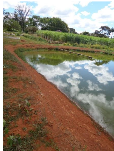
Figura 4.16 - Lagoa de polimento da ETE Silva Campos Fonte: COBRAPE (2014)
