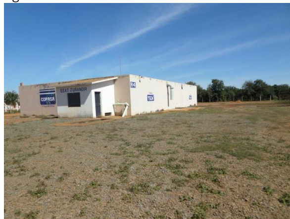
Figura 4.5 - Reservatório R4 e elevatória de água tratada EEAT Jurandir
