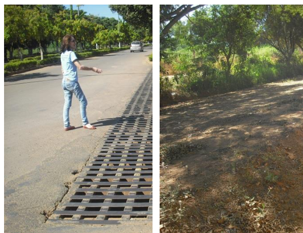
Captção de águas pluviais, Avenida Capitão Joaquim Antônio com Rua Olegário Maciel - Sede
