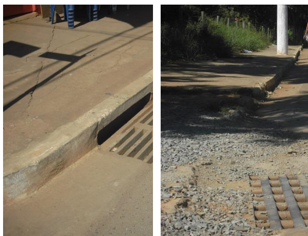
Galeria de Águas Pluviais – GAP, Rua Padre João Porto
