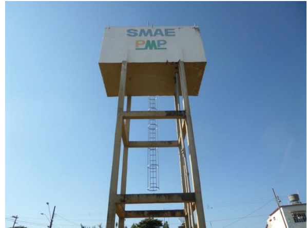
Figura 4.6 - Reservatório Cojanna Sede Fonte: COBRAPE (2014)
