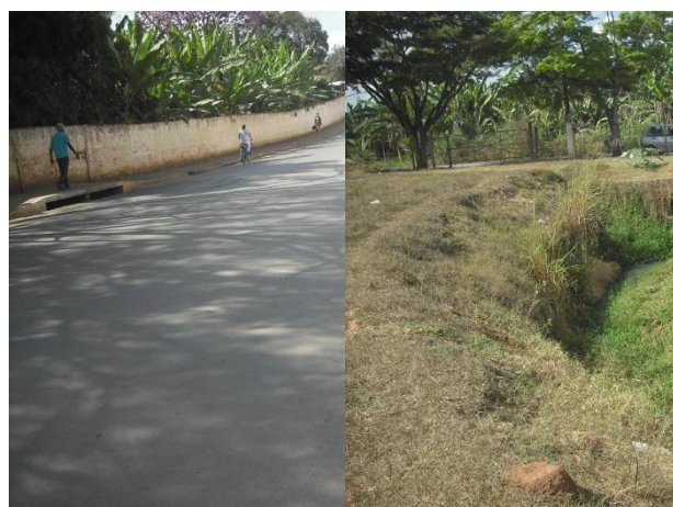
Travessia sobre o Córrego Pontinha, Rua Santo Antônio
