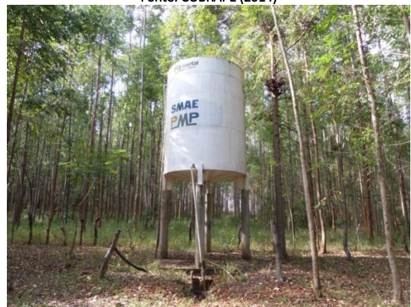
Figura 4.7–Reservatório 2 em Riacho de Areia Fonte: COBRAPE (2014)
