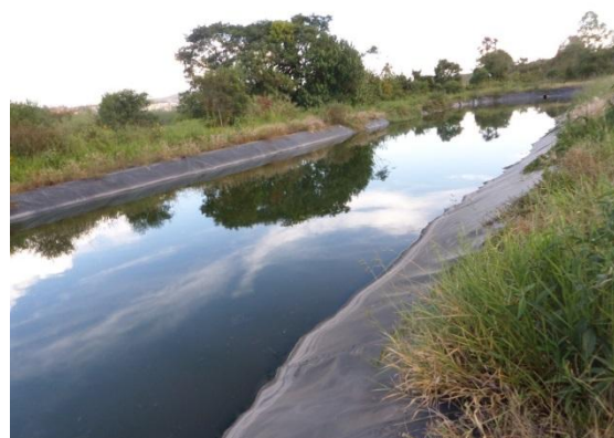
Figura 4.10 – Lagoa de maturação operada pelo SMAE
