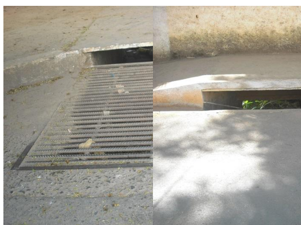
Captação de Água Pluvial encaminha águas direto para o Córrego Pontinha, Rua Santo Antônio
