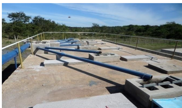
Figura 4.6 – Reatores Anaeróbios de Fluxo Ascendente Fonte: COBRAPE (2014)
