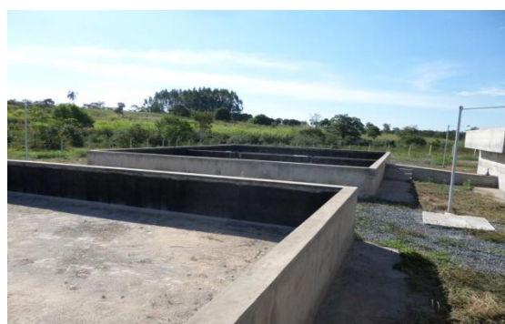
Figura 4.8 – Leitos de secagem Fonte: COBRAPE (2014)
