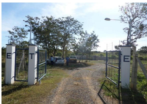
Figura 4.5 – Entrada da ETE da sede de Moema Fonte: COBRAPE (2014)
