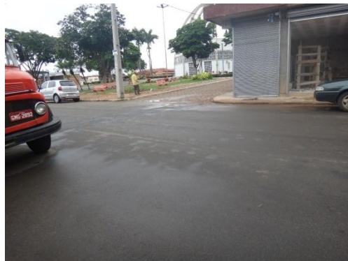
Figura 4.18 – Guias e Sarjetas na Rua Tupis – Centro
