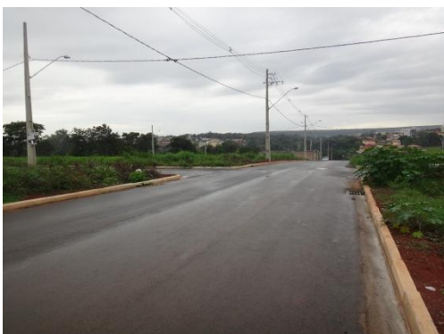
Figura 4.20 – Captações e galerias de águas pluviais no Loteamento dos Ipês
